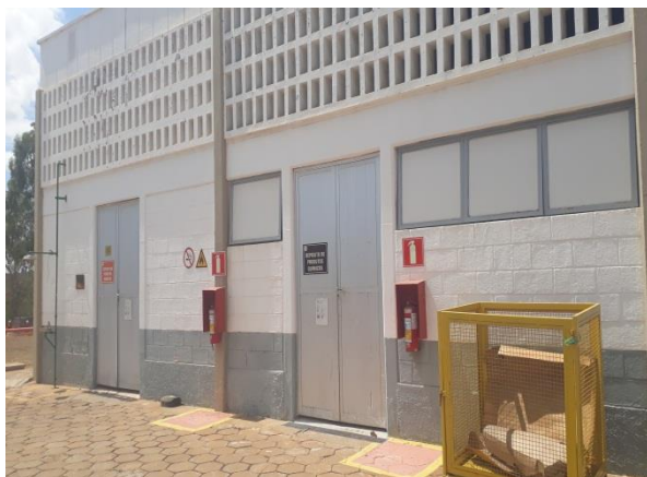
Foto 11 – Depósito de produtos químicos
