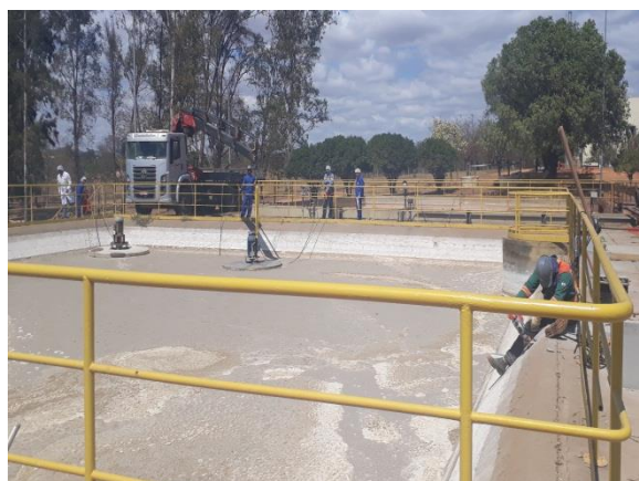
Foto 8 – Tanque de aeração da PTAR
