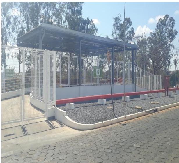
Foto 4 – Entrada do depósito temporário de resíduos
