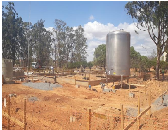
Foto 10 – PTAR em operação e em modificação
