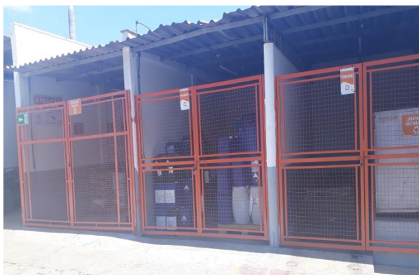
Foto 5 – Depósito temporário de produtos perigosos
