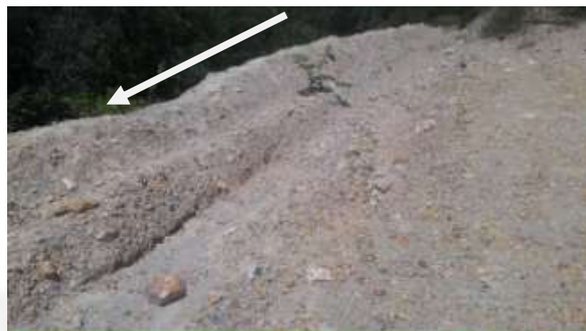
Barreiras implantadas próximo à frente de lavra 02 para evitar carregamento de sedimentos
