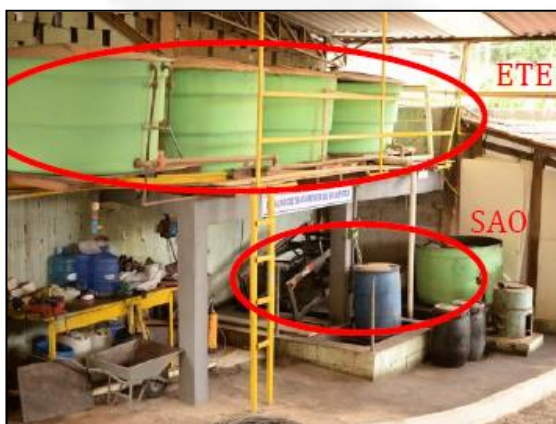
Foto 05. Sistema de Tratamento de Efluentes líquidos industriais, composto por SAO e ETE.
