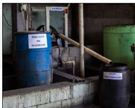
Foto 06. Detalhe do sistema de recolhimento do óleo sobrenadante pelo equipamento Skimer.
