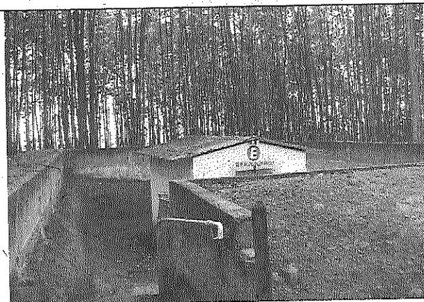
Foto 1: Depósito de pólvora negra.
