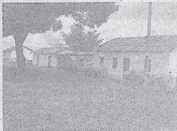
Foto 04. Casas na sede
