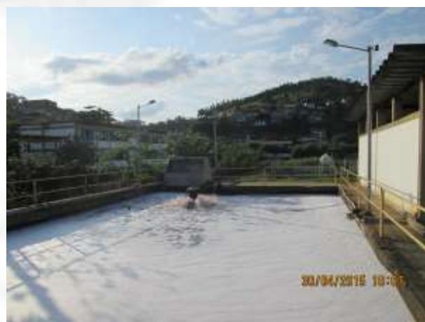
Figura 16: Tanque de neutralização e equalização.
