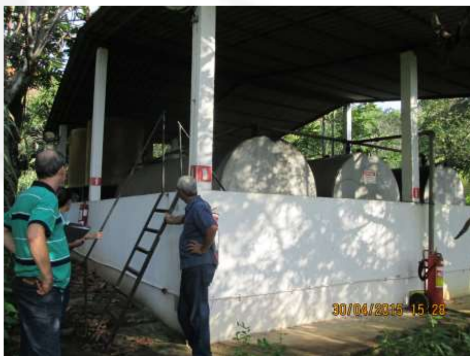
Figura 03: Armazenamento de óleo diesel.
