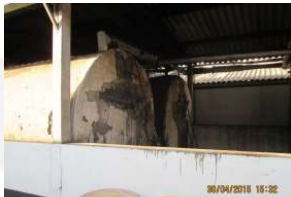
Figura 05: Tanques de óleo combustível - caldeiras.
