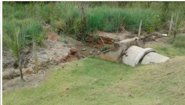
Foto 04. Manilha instalada para direcionar a água pluvial para o córrego.
