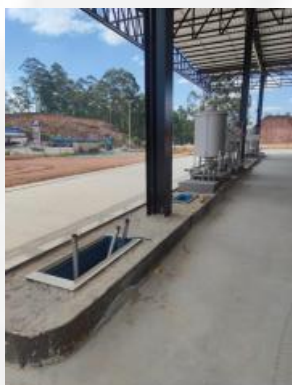
Foto 3: Ilhas de abastecimento de diesel, equipadas com filtros, sumps e tubulações.
