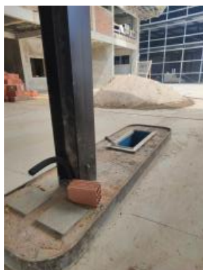
Foto 4: Ilha de abastecimento de gasolina/etanol, equipadas com sump e tubulações.
