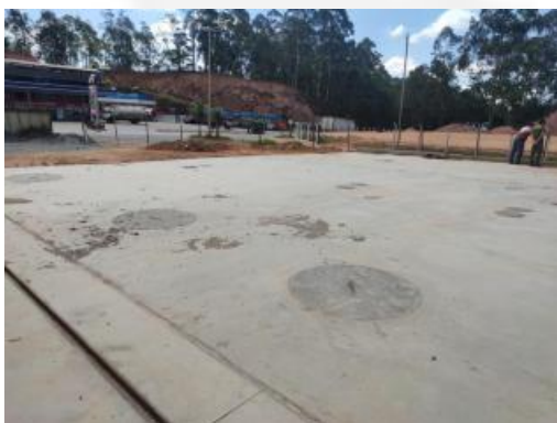
Foto 6: Área do SASC e canaletas de drenagem.
