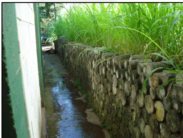
Reaproveitamento dos corpos de prova no próprio empreendimento
