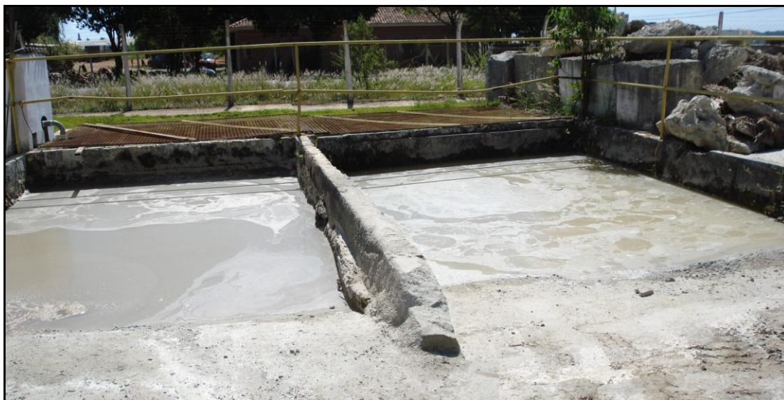
Sistema de decantação – bata-astro
