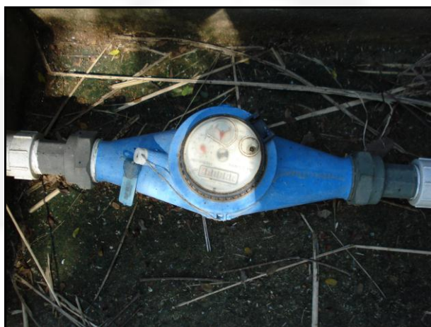
Hidrômetro do poço tubular
