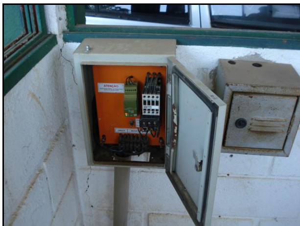
Acionamento da bomba do poço tubular
