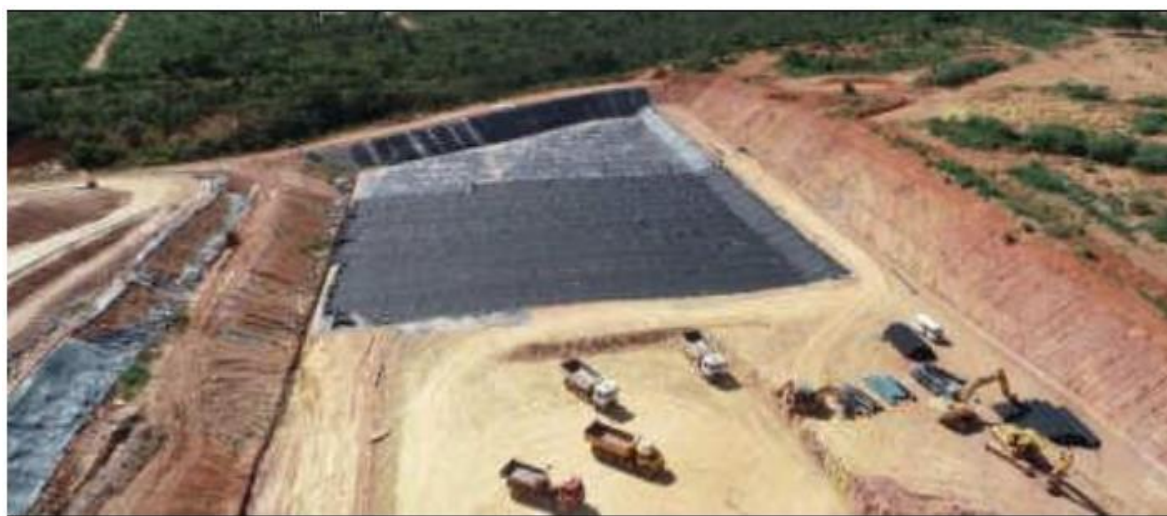
Figura 3. Sistema misto de impermeabilização de base e taludes (solo compactado + geomembrana de PEAD) sendo instalada em aterro sanitário em concepção semelhante ao empreendimento (Fonte: EIA/RIMA; UVS Montes Claros, VIASOLO).
