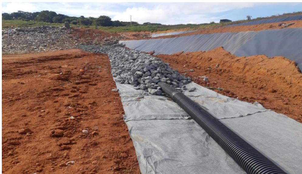
Figura 4. Sistemas de impermeabilização de base e taludes (solo compactado + geomembrana de PEAD) e de drenagem interna de efluentes instalados em um aterro sanitário, em configuração similar àquela prevista para o empreendimento. (Fonte: EIA/RIMA; CTR Leopoldina).
