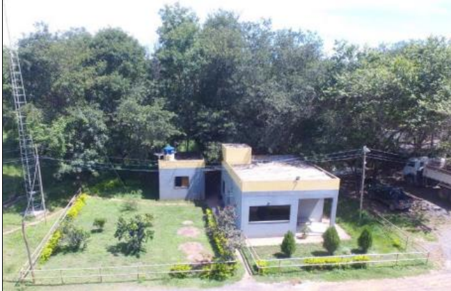
Foto 05. Estrutura de apoio (escritório, alojamento e refeitório).
