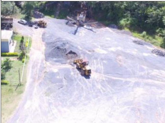
Foto 03. Visão geral do britador e pátio de acumulação de produtos.
