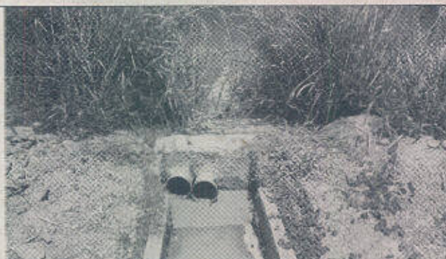
Foto 3. Canaleta de águas residuárias
