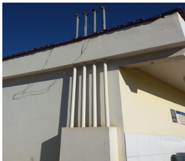
Foto 04: Respiros dos tanques subterrâneos.
