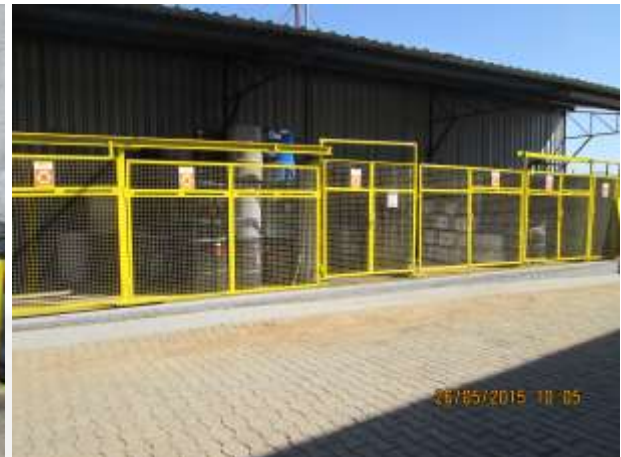
Foto 06. Depósito Temporário de Resíduos Classe I
