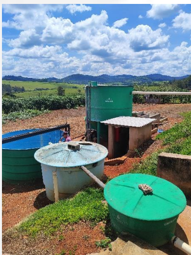
Figura 15: Estação de tratamento de efluentes industriais
