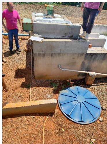
Figura 18: Tanque de equalização
