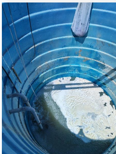
Figura 17: Caixa de resfriamento e armazenamento de efluente
