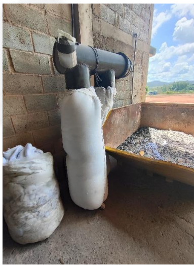
Figura 12: Filtro para retenção de resíduos da lavagem e caçamba com cinza
