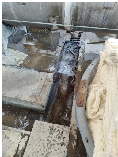
Figura 7: Canaletas que direcionam o efluente
