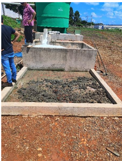
Figura 19: Tanque de equalização e leito de secagem
