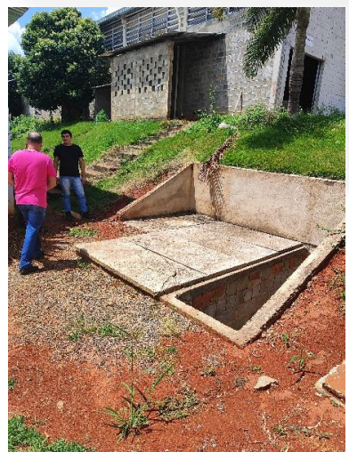
Figura 23: Biodigestores – efluente sanitário
