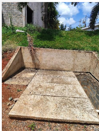
Figura 24: Biodigestores – efluente sanitário
