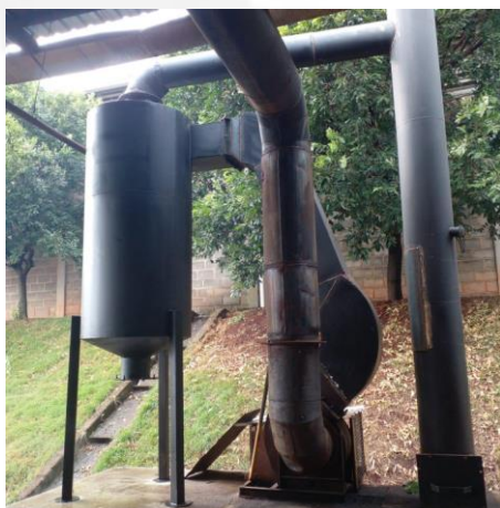
Figura 2: Filtro multiciclone instalado na caldeira do empreendimento
