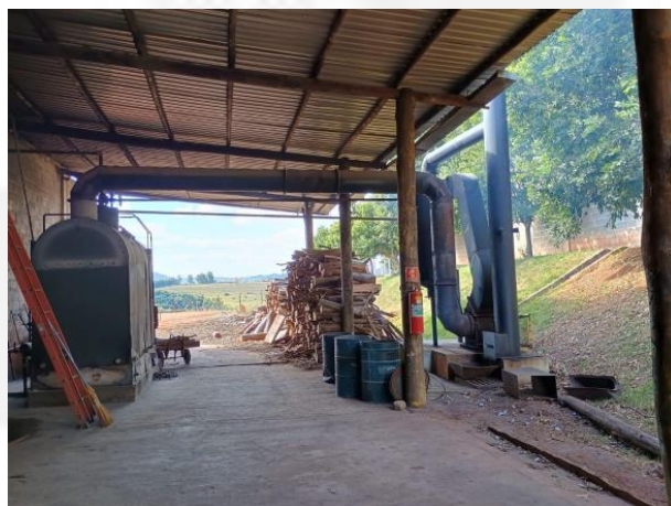
Figura 2: Filtro multiciclone instalado na caldeira do empreendimento
