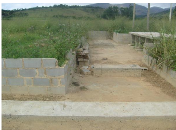
Fotos da vistoria: Parte da estrutura do empreendimento já construída
