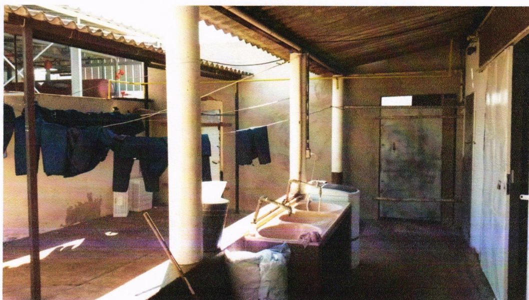
Figura 48: Vista da varanda do prédio Refeitório.
