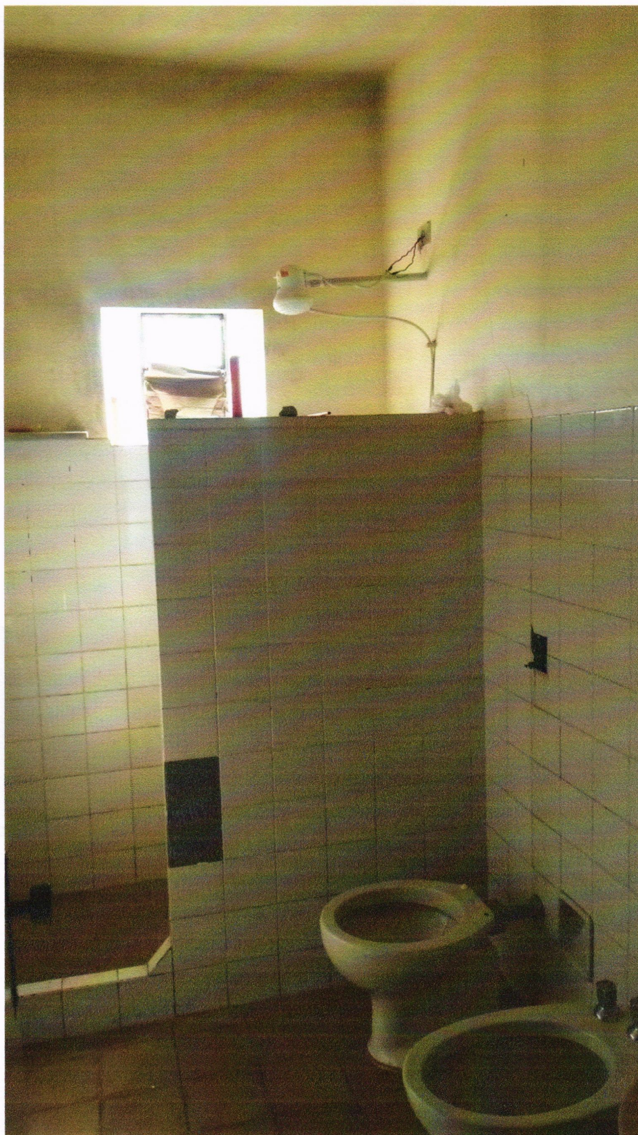
Figura 54: Vista interna do banheiro social da Residência dos Funcionários.
