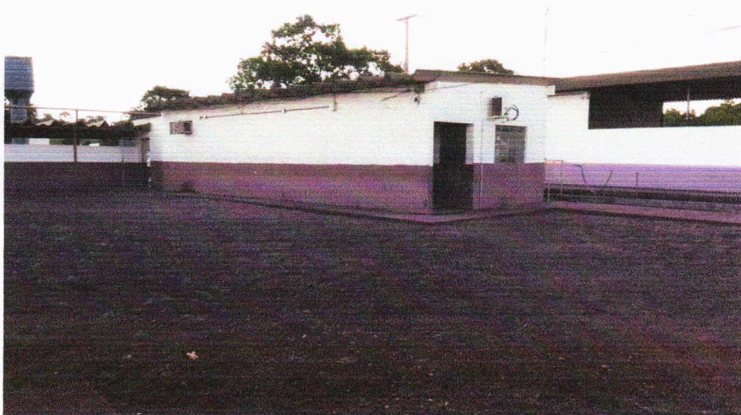
Figura 41: Vista externa do prédio da Balança/Administrativo.
