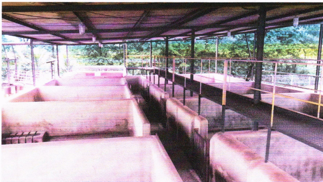
Figura 25: Vista interna da pocilga. Destaque para a passarela em chapa xadrez expandida e alvenarias em concreto aparente com altura de 1,25 metros.
