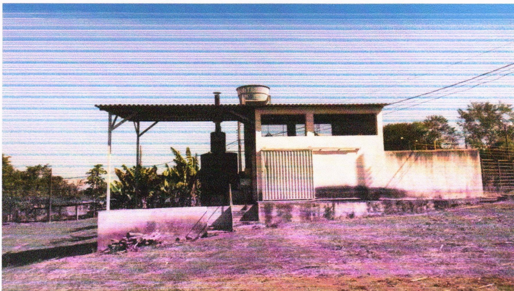
Figura 27: Vista externa do incinerador.
