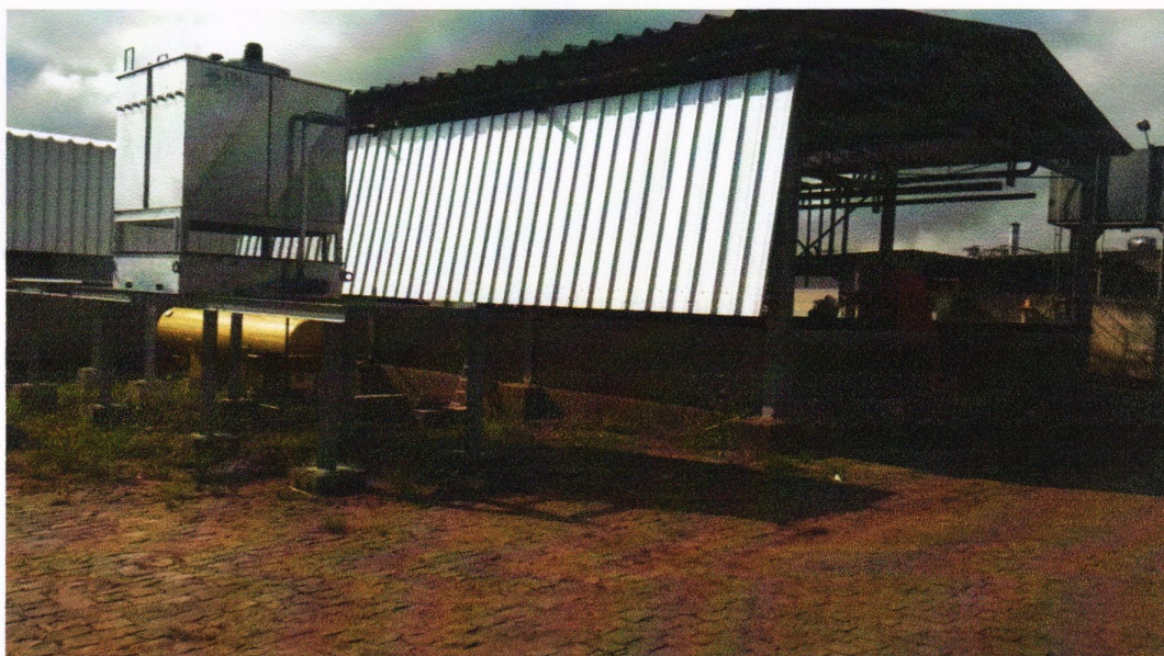
Figura 50: Vista externa do prédio da Casa de Máquinas.
