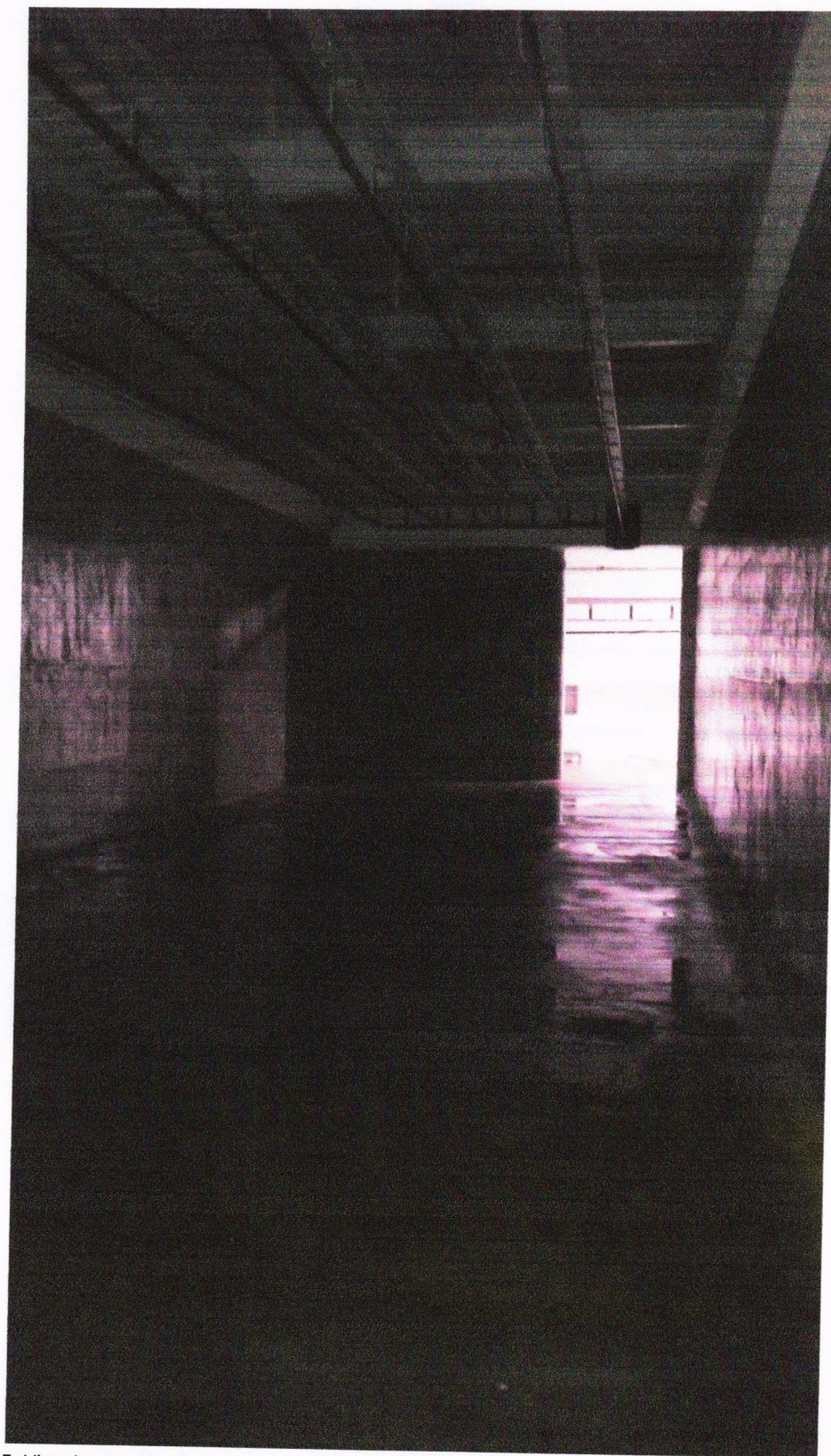
Figura 5: Vista interna da câmara 2 no setor de armazenamento intermediários. Pisos e paredes em concreto aparente e teto com isolante de poliestireno expandido.
