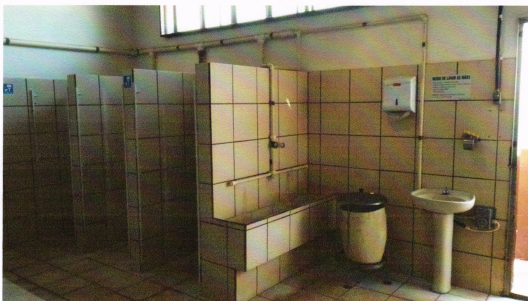
Figura 47: Vista interna do vestiário do refeitório.
