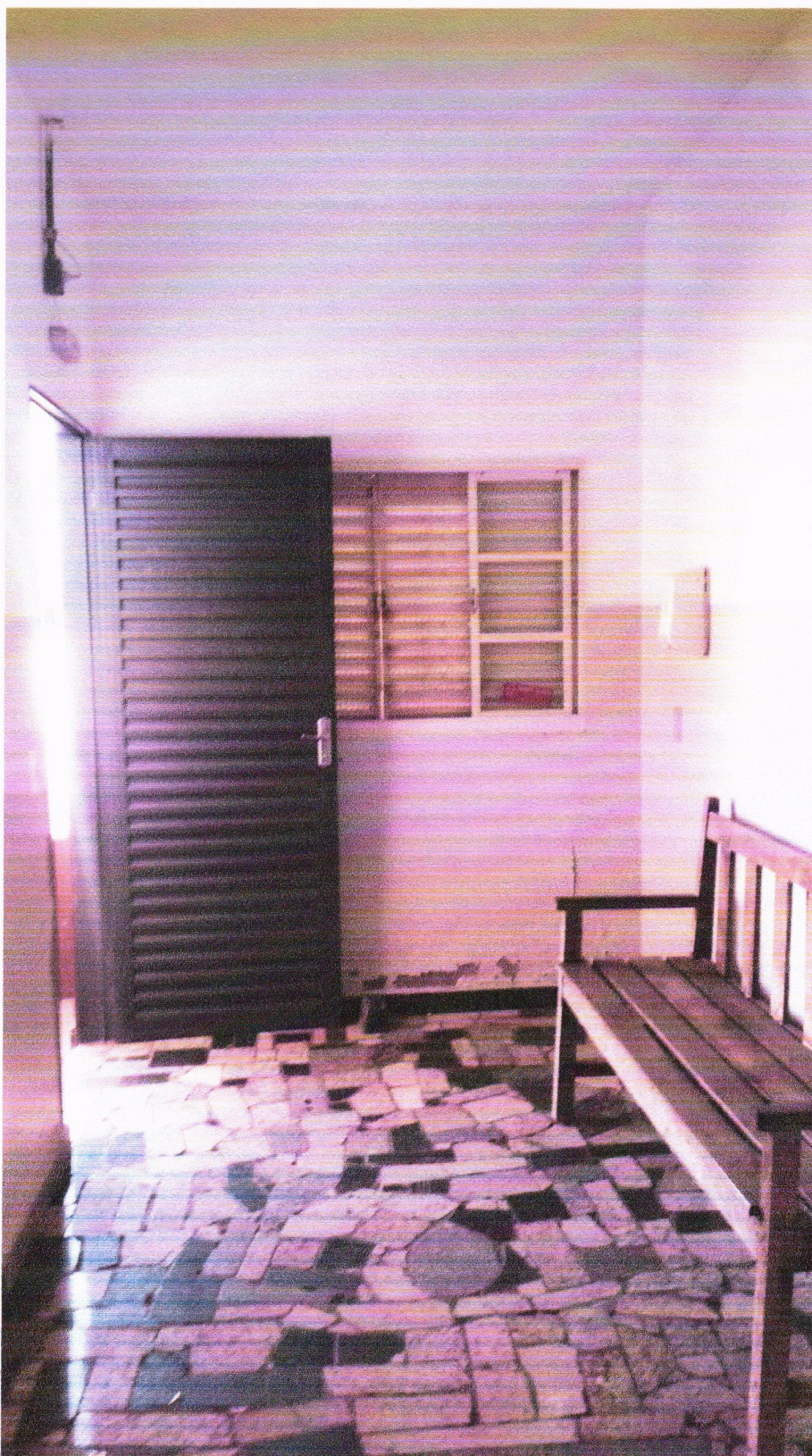
Figura 38: Vista interna do prédio do SIF.
