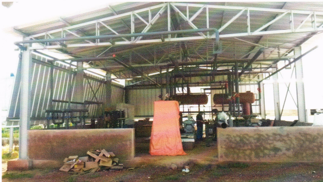
Figura 49: Vista externa do prédio da Casa de Máquinas.
