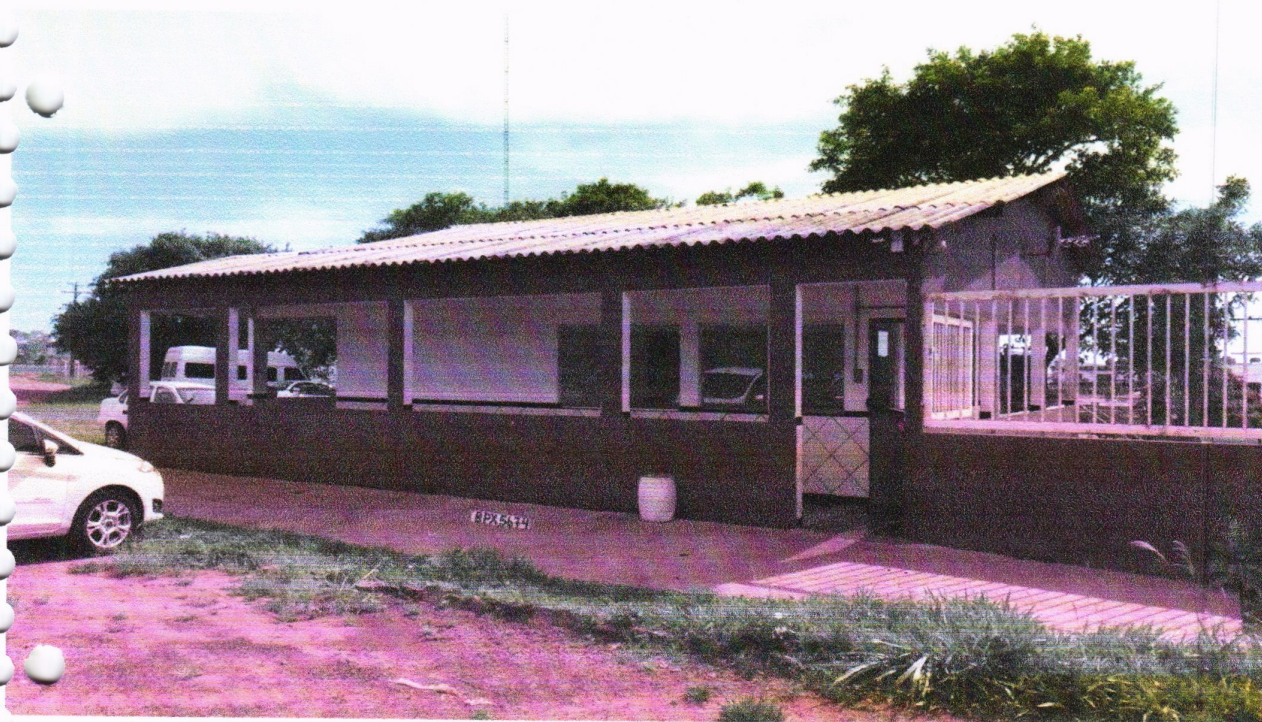
Figura 29: Fachada frontal do edifício portaria.
