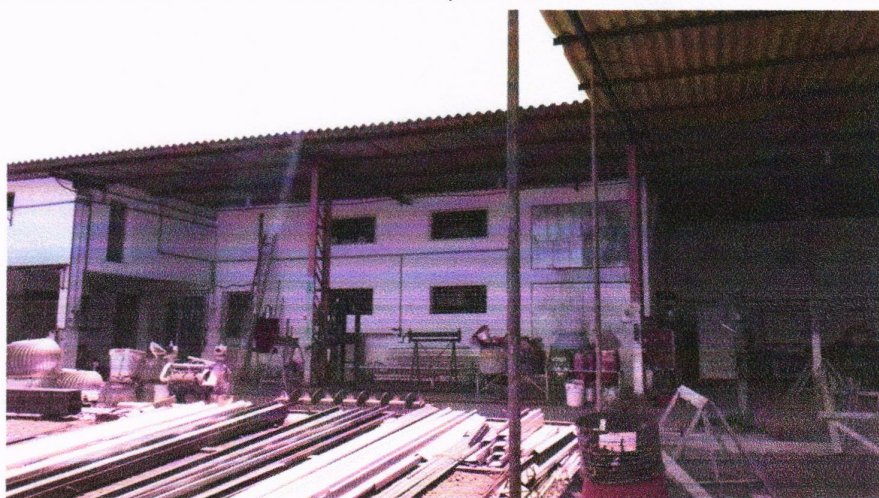
Figura 10: Vista do pavimento térreo do edifício da oficina.
