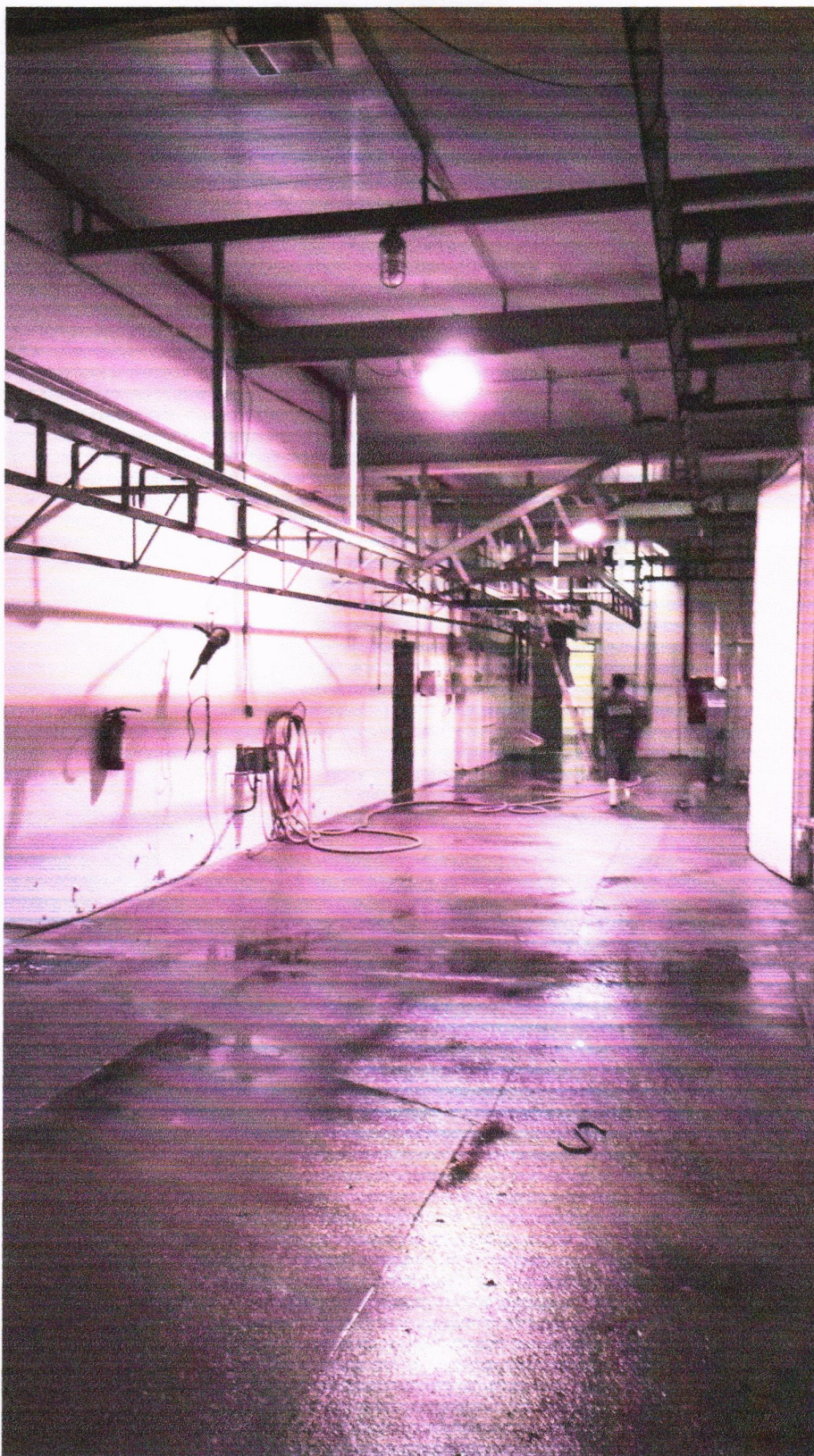
Figura 6: Vista interna do tendal de embarque. Piso em concreto desempenado, alvenarias com pintura acrílica e forro em isopainéis.
