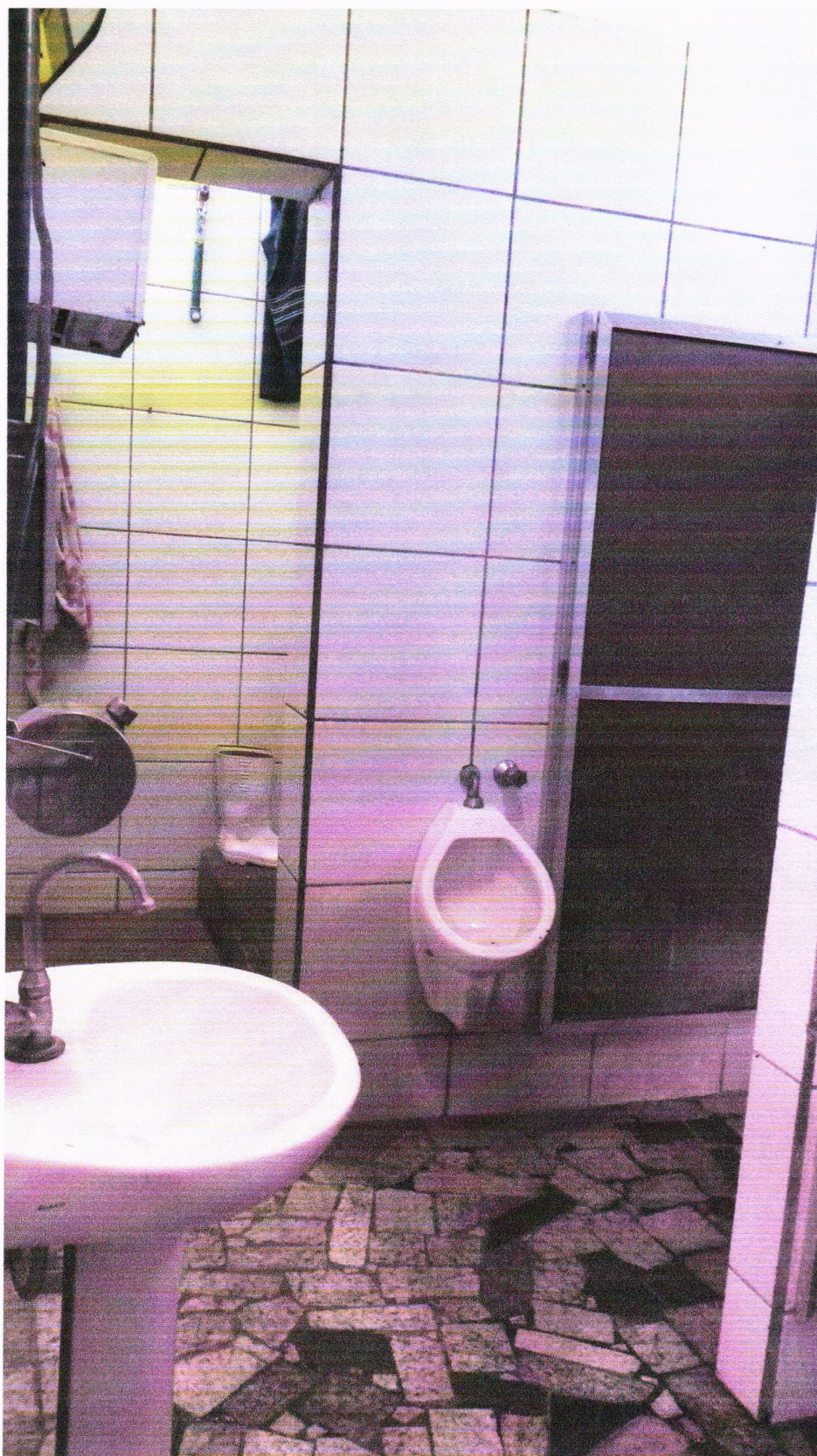
Figura 20: Vista interna do banheiro situado entre a caldeira e a graxaria.
