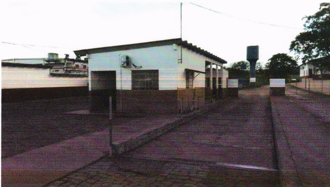
Figura 40: Vista externa do prédio da Balança/Administrativo.
