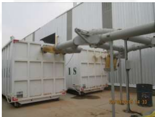
Contêineres de armazenamento de material particulado.
