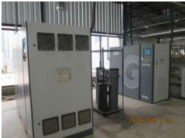
Fig. 9 – Bateria de compressores com filtro acoplado, não há geração de purga para o ambiente.
