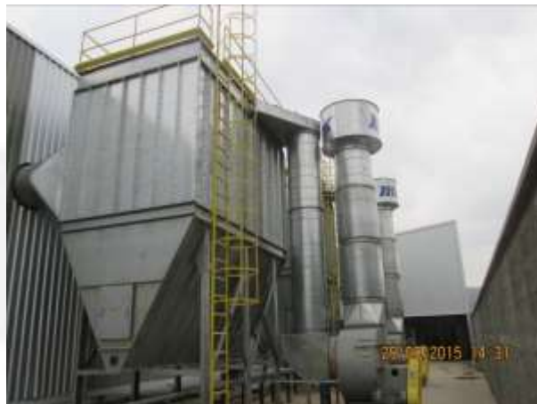
Fig. 10 – Sistema de despoeiramento do empreendimento, não possui silos suspensos, sistema composto por contêiner.
