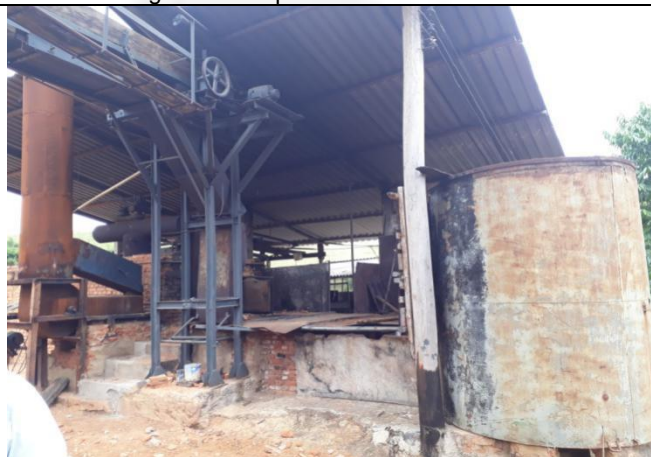
Foto 3: Forno da caldeira em reforma.
