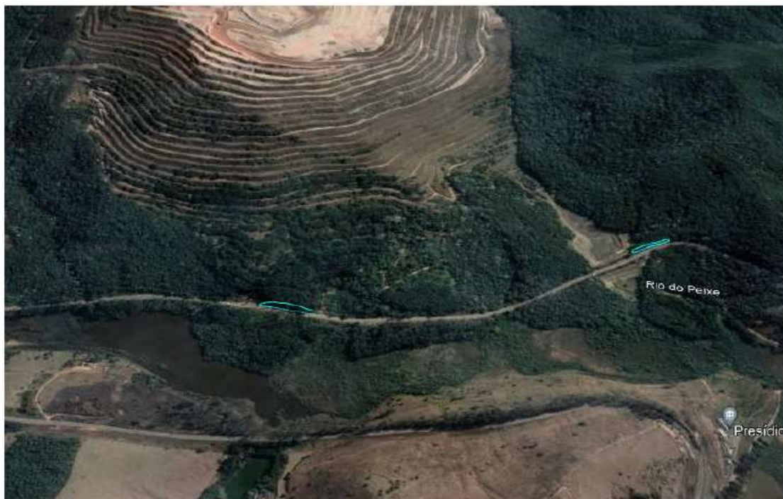
Figura 11: Destaques para as áreas de de entrada e saída da rodovia. Fonte: Informações Complementares.
