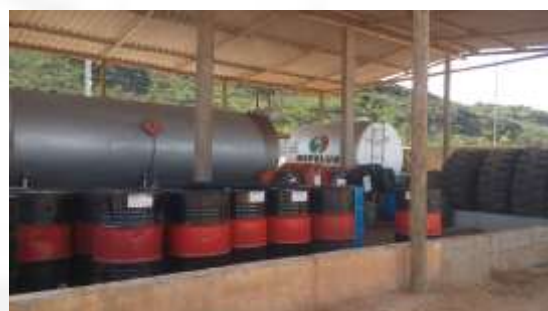
Pátio armazenamento combustíveis com caixa de contenção
