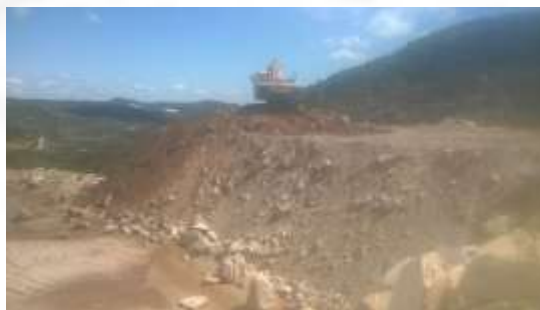
Obras de conformação da bacia de contenção de sedimentos
