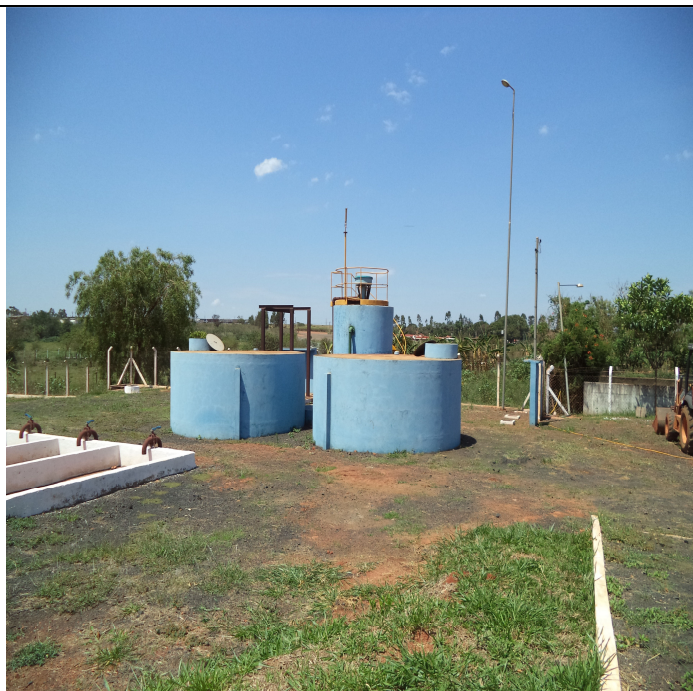
Estação de tratamento de efluentes- ETEI –RAFA e Filtros Biológicos
