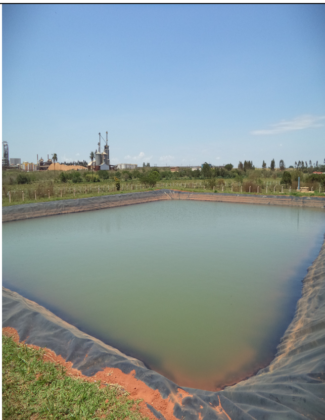
Sistema de tratamento de efluentes – ETEI – Lagoa de reúso
