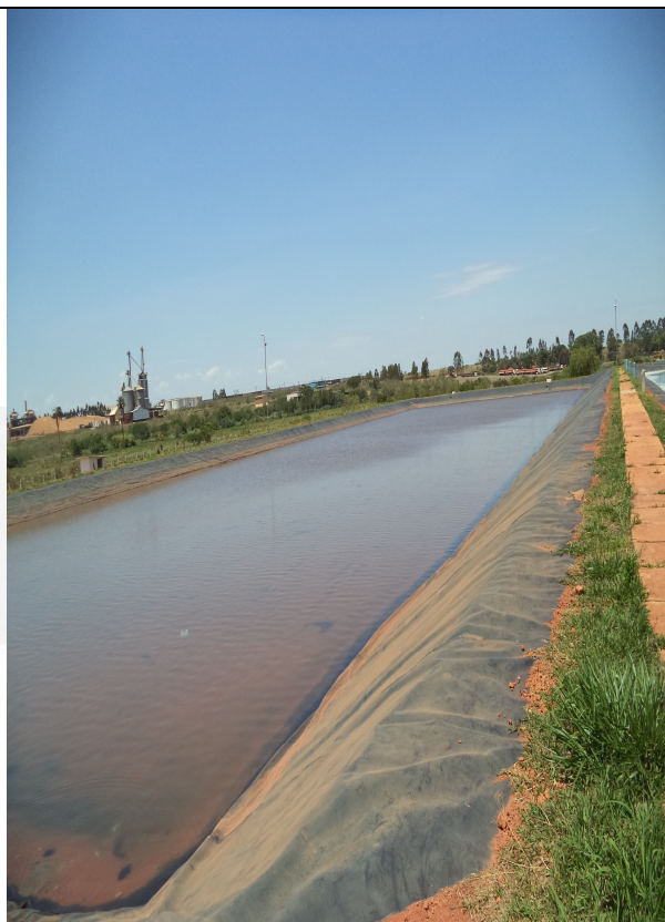
Sistema de tratamento de efluentes – ETEI – Lagoa de maturação
