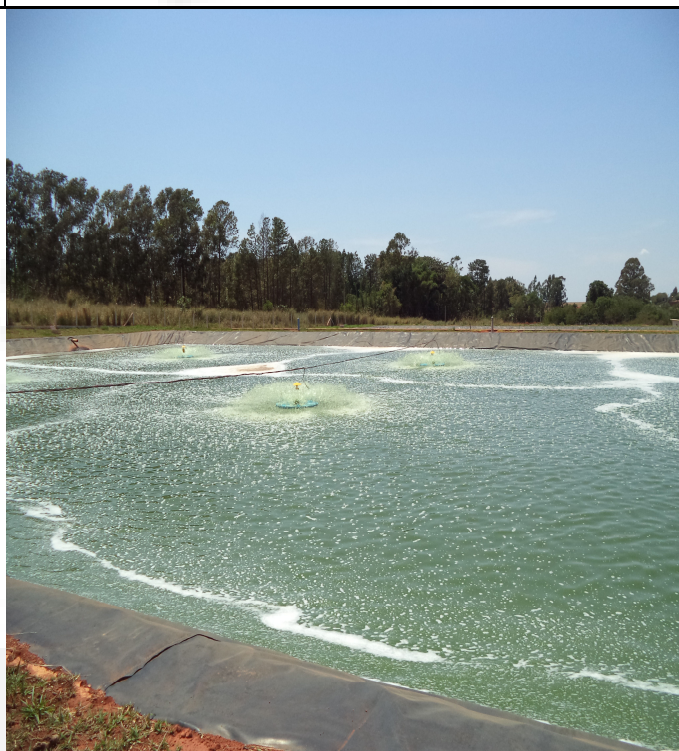
Estação de tratamento de efluentes- ETEI - Lagoa Aerada
