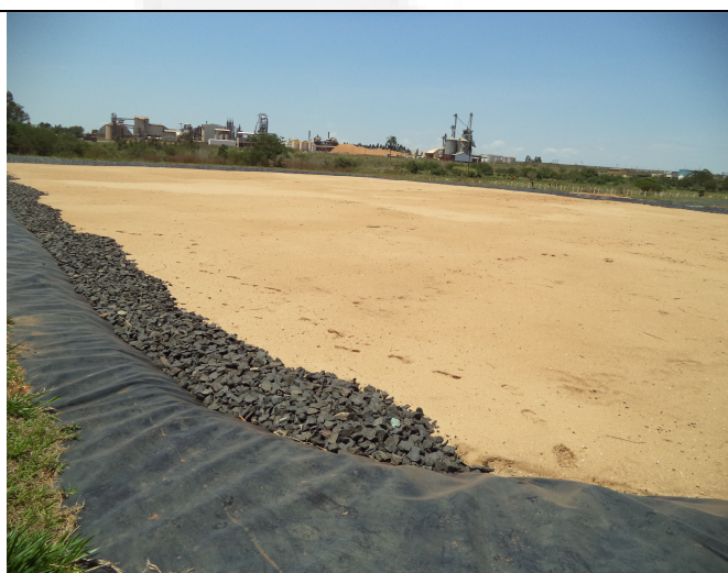
Sistema de tratamento de efluentes –ETEI – Lagoa de polimento (zona de raízes)
