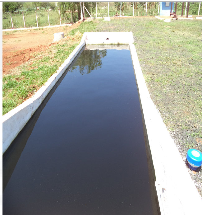
Estação de tratamento de efluentes – ETEI – Decantador quimicamente assistido
