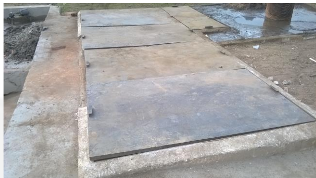
Foto 02: Caixa separadora de água e óleo
