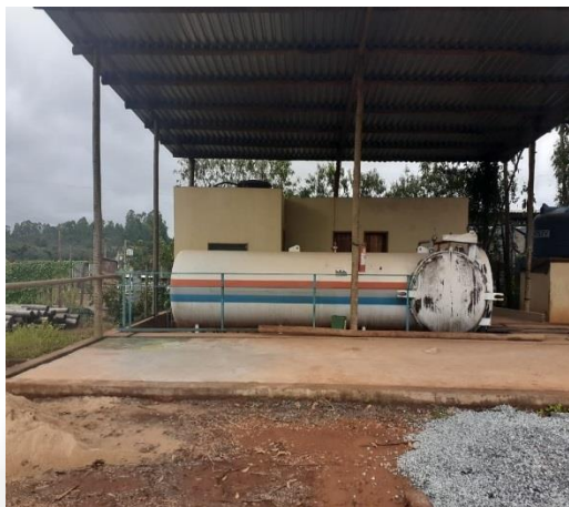
Foto 01. Autoclave utilizada no tratamento da madeira
