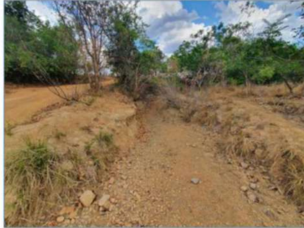
Figura 3-5 Solo erodido próximo ao Córrego Buriti
