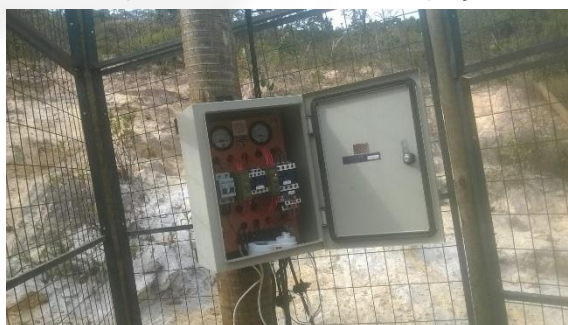
Foto 08 quadro de comando do poço tubular
