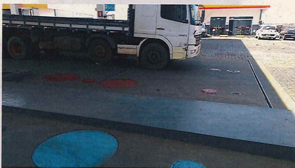
Foto 01. Área dos tanques
