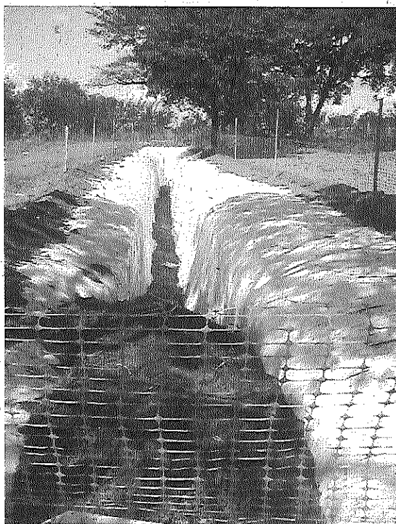
Foto 03. Vala de aterro sendo preenchida com lodo proveniente do leito de secagem.
