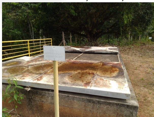
Foto 10 – Sistema separador de água e óleo.
