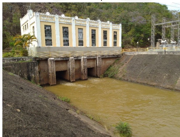
Foto 06 - Canal de fuga da casa de força.
