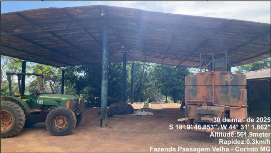
Fotos 4 a 7. Galpão de manutenção de equipamentos.
