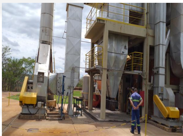
Sistema multiclone. Caldeira a biomassa.
