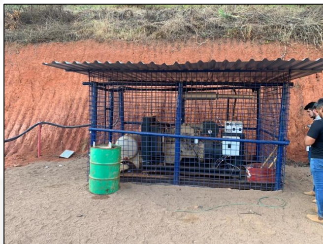
Foto 04 – Motor a diesel a ser utilizado na operação do empreendimento.
