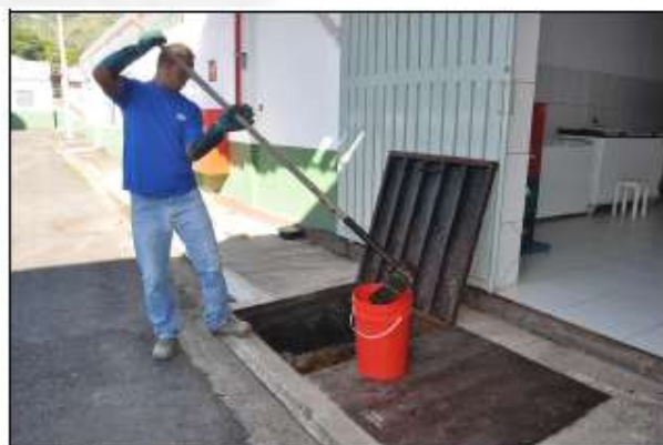
Foto 22 – Limpeza manual da caixa de gordura
