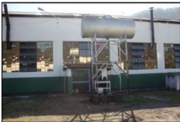
Foto 32 – Reservatório de óleo diesel antes da adequação
