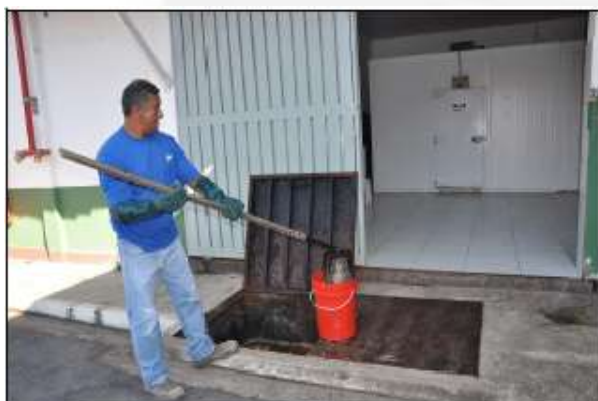
Foto 22 – Limpeza manual da caixa de gordura
