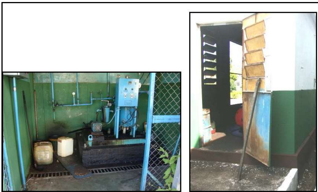
Foto 34 – Compressores antes da adequação
