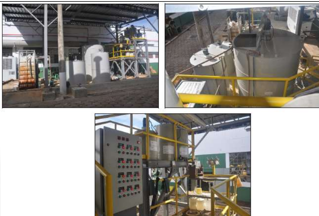
Foto 19 - Construção da Estação de Tratamento de Efluentes Industriais (ETEI)
