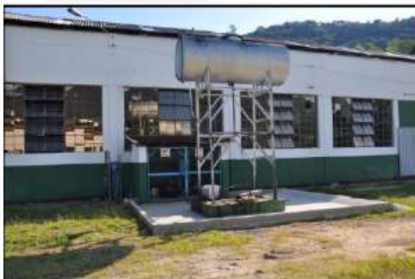
Foto 33 – Reservatório de óleo diesel após a adequação
