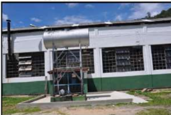
Foto 33 – Reservatório de óleo diesel após a adequação
