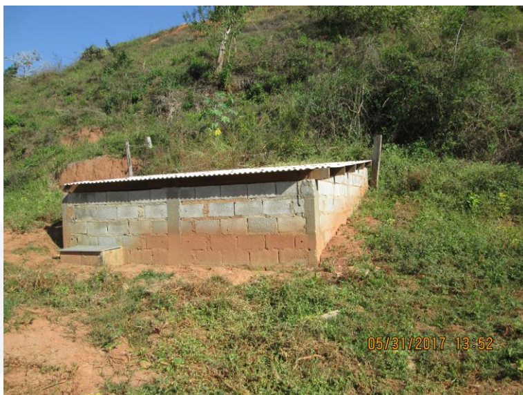
Figura 07: Fossa séptica instalada no galpão de acabamento das pedras.
