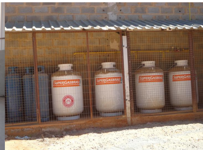
Figura 13: Armazenamento do GLP.
