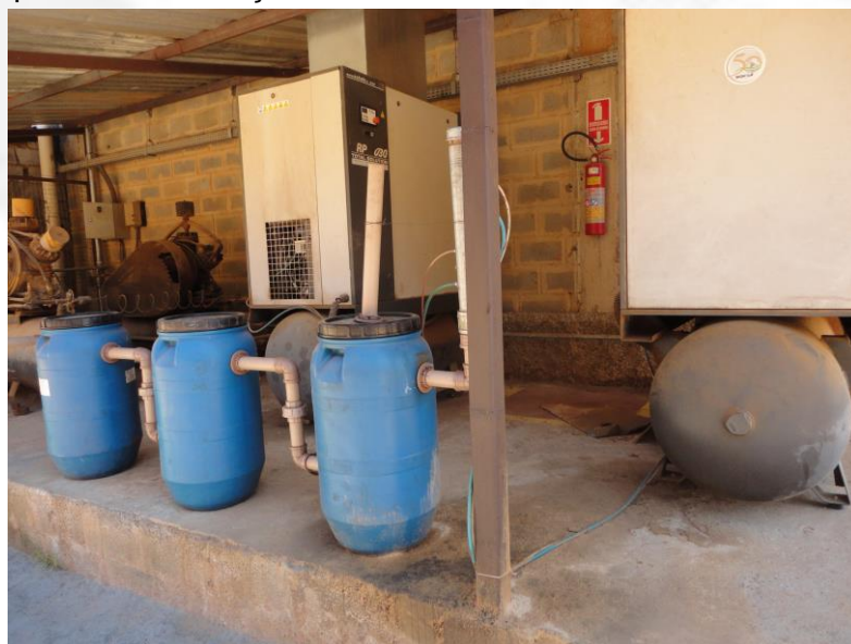
Figura 06: Caixa SAO instalada para o tratamento da água de purga dos
