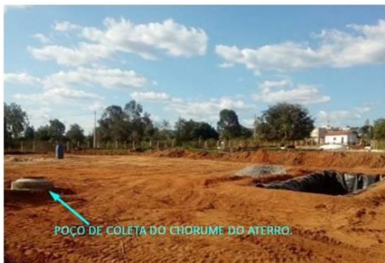
Poço de coleta do chorume do Aterro de Pequeno Porte.
