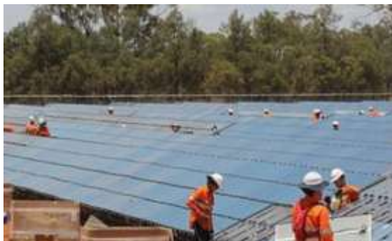
Figura 6 - Ilustração da montagem dos módulos fotovoltaicos Fonte: PCA - 2016
