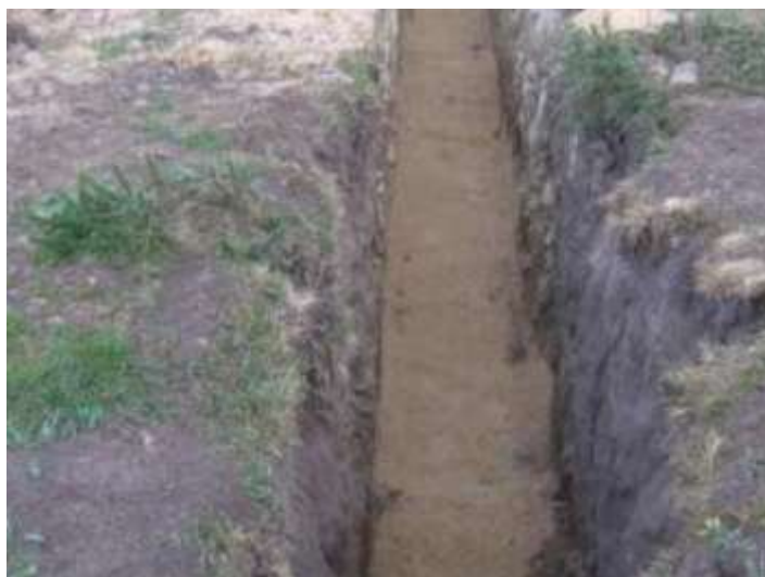
Figura 9 - Ilustração da abertura das valas para execução da passagem dos cabos. Fonte: PCA, 2016
