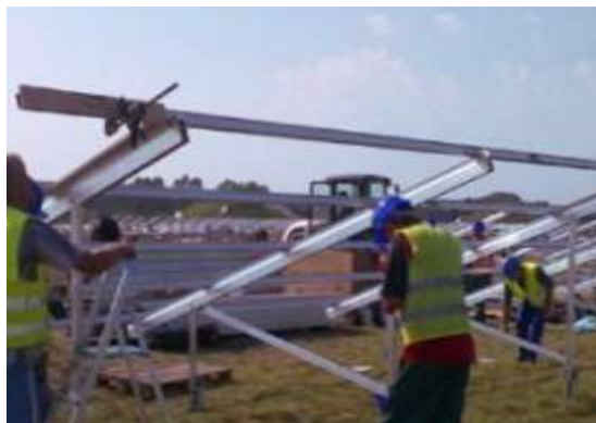
Figura 4 - Ilustração das estruturas de apoio dos módulos fotovoltaicos Fonte: PCA, 2016
