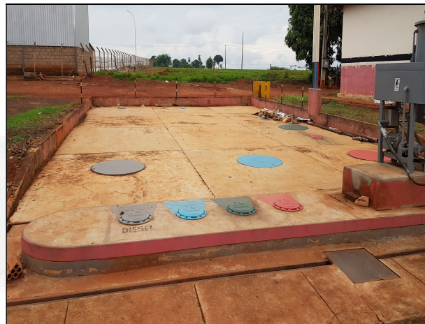
Figura 2: Tanques subterrâneos, filtros e pista de descarga.
