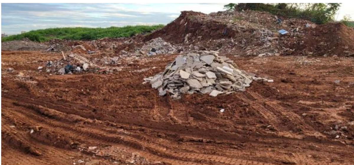
Resíduos inertes Classe A segregados dos resíduos RCC na área de triagem do UTTA-RCC Paracatu e já prontos para reuso como revestimento primário de estradas.
