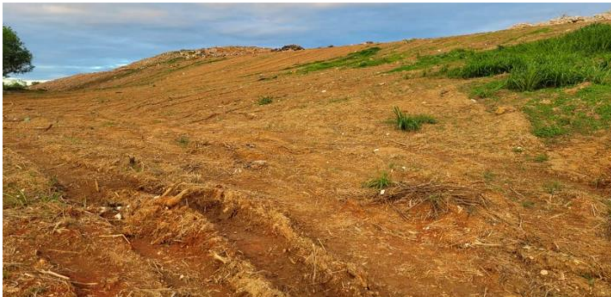
Maciços de resíduos inertes (Classe B) de RCC devidamente conformados no Aterro de RCC da UTTA-RCC 1.
