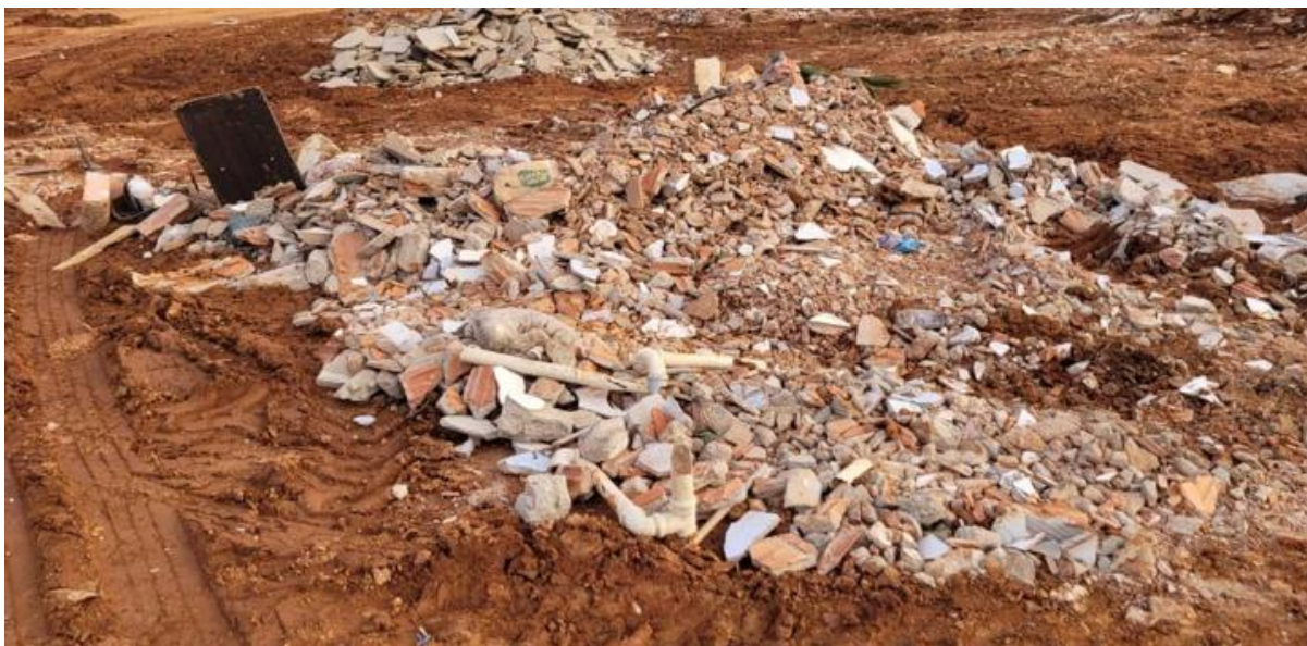
Resíduos inertes Classe A segregados dos resíduos RCC na área de triagem do UTTA-RCC Paracatu e já prontos para reuso como revestimento primário de estradas.
