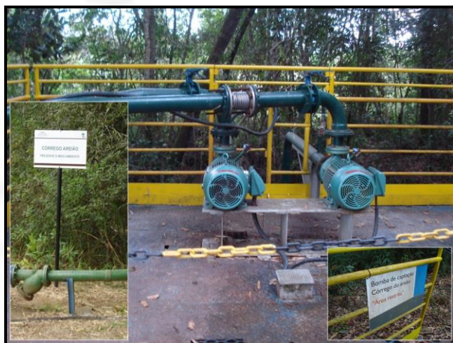
Foto 11 – Detalhe do local de captação de água superficial com placa indicativa e educativa.
