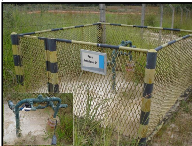
Foto 10 – Detalhe do poço tubular profundo.
