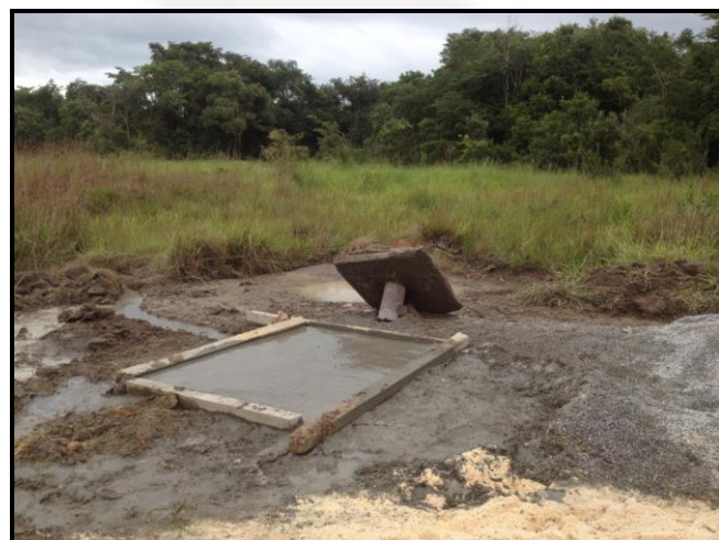
Foto 12 – Detalhe da finalização do tamponamento do poço 02 com execução da caixa de proteção.
