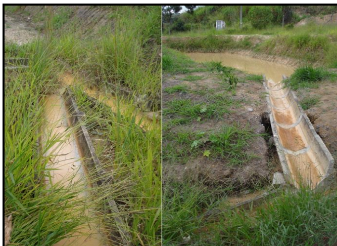
Foto 8 – Detalhe de canaletas pré-moldadas para direcionamento de efluentes líquidos e águas pluviais.
