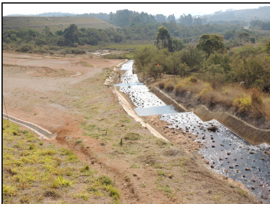
Figura 02 – Canalização e retificação do Córrego do Papão na ARB 3 (Células 1 e 2)
