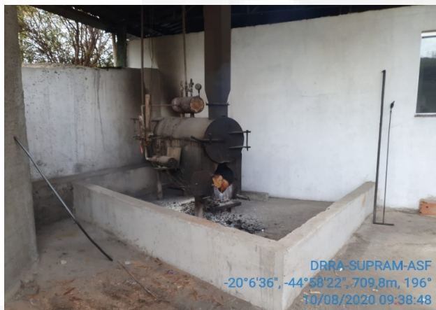
Figura 1: Impermeabilização e bacia de contenção da caldeira
