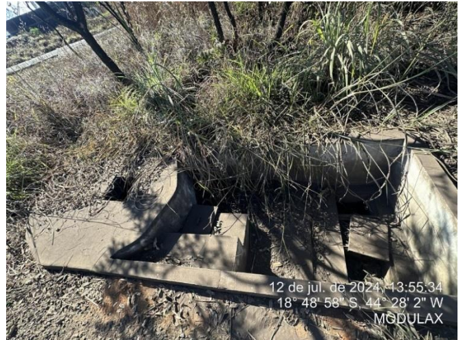
Foto 74: CSAO do Posto de combustível desativado.
