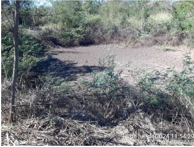
Foto 31: Bacia de decantação que recebe o efluente da bacia de chegada do efluente.
