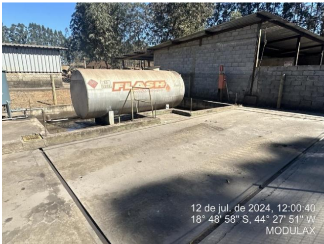
Foto 69: Vista do posto de combustível em operação. Presença de canaleta somente de frente o reservatório.
