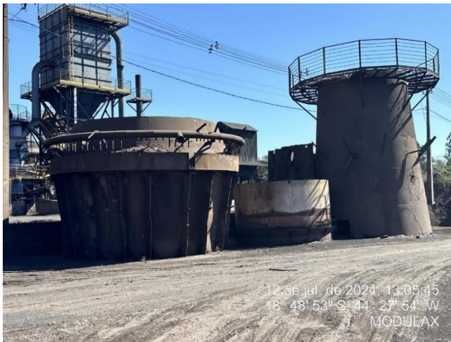
Foto 3: Painela a ser instalada, após o licenciamento
