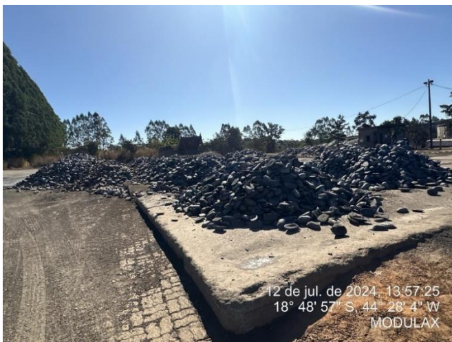
Foto 83: Pátio de lingotes com pavimentação.
