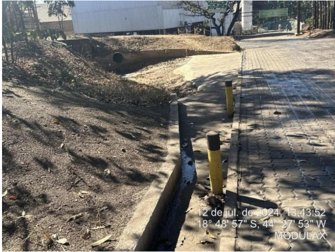
Foto 25: Canaleta de drenagem na via de acesso ao laboratório.
