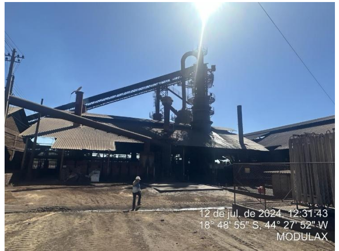
Foto 2: Vista geral da estrutura do alto-forno da Modulax, evidenciando que não há avarias na mesma.
