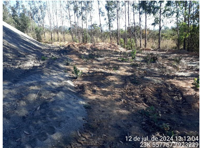
Foto 82: Sump que recebe água de escoamento superficial das estruturas de direcionamento de água ao redor da pilha de escória.
