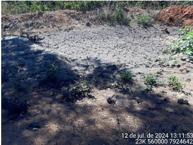
Foto 81: Sump para recebimento de parte da drenagem superficial da pilha de escória.
