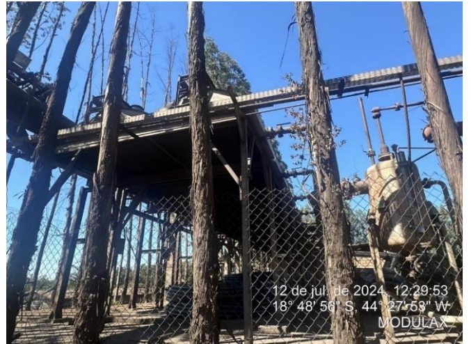
Foto 38: Ventiladores que contemplam sistema de resfriamento dos vapores da termelétrica, para que os mesmos sejam condensados, e a água reaproveitada
