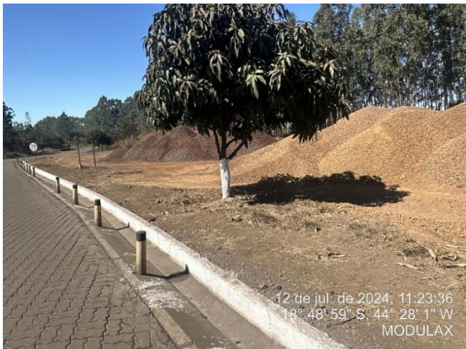
Foto 41: Pátio de minério, com vista lateral evidenciando canaleta de drenagem
