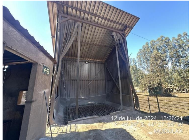
Foto 44: Silo de alimentação de minério no alto-forno (parte traseira do mesmo, onde o caminhão deposita os minérios)
