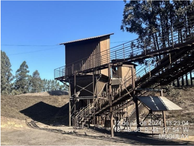
Foto 43: Silo de alimentação de minério no alto-forno (vista de frente da estrutura)
