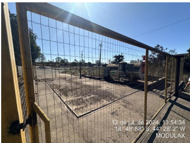
Foto 71: Vista do posto de combustível desativado.
