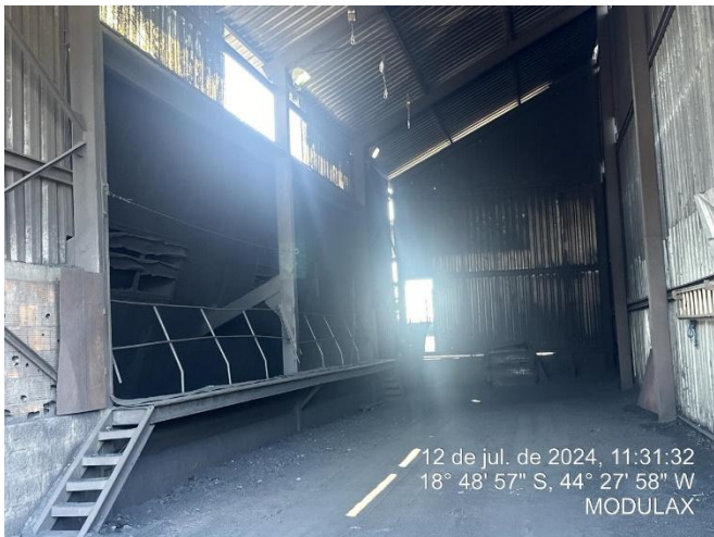
Foto 17: Vista interna do galpão de carvão que o empreendedor informou estar desativado
