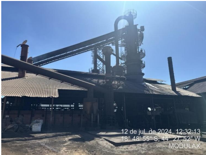
Foto 1: Vista geral da estrutura do alto-forno da Modulax.
