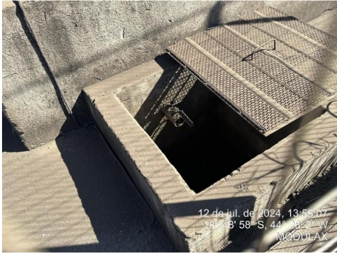
Foto 73: Área associada ao Posto de combustível desativado.
