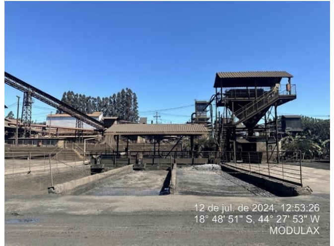
Foto 8: Tanque de pó de balão
