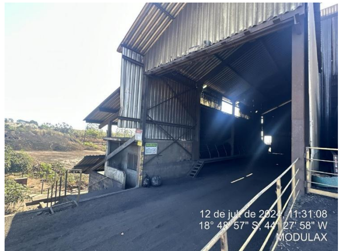
Foto 18: Galpão de carvão que o empreendedor informou estar desativado.
