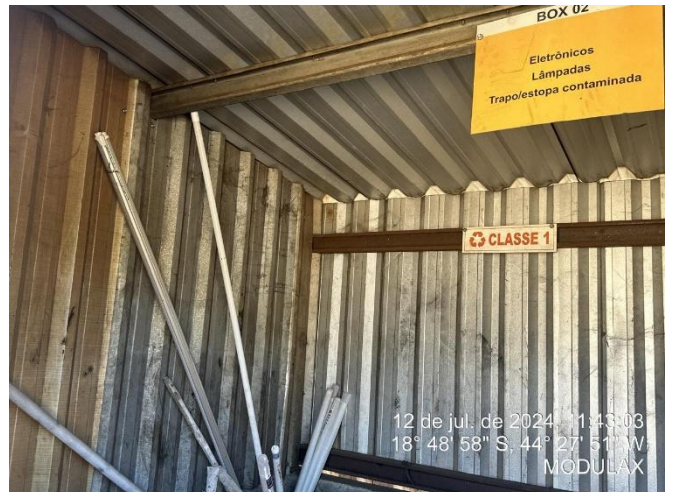
Foto 48: Local de armazenamento de resíduos classe I.
