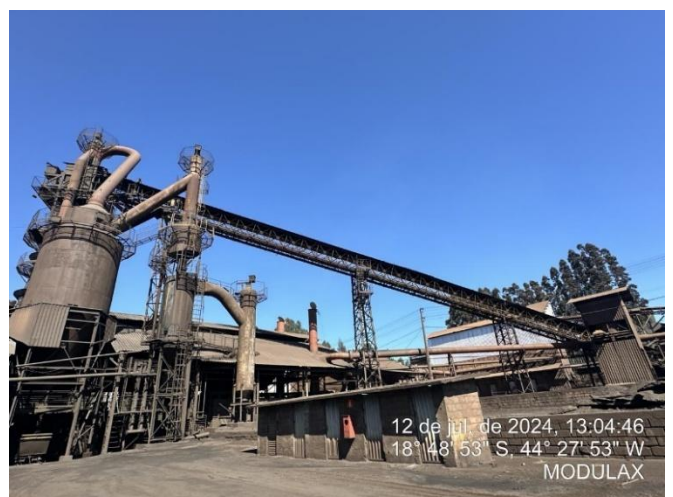
Foto 6: Lavador de gás e balão gravimétrico, vistos juntamente com o complexo industrial do alto-forno
