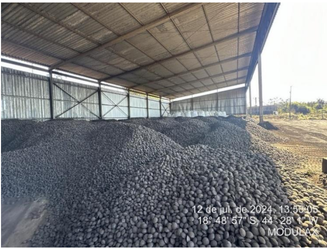
Foto 45: Galpão de armazenamento de briquetes
