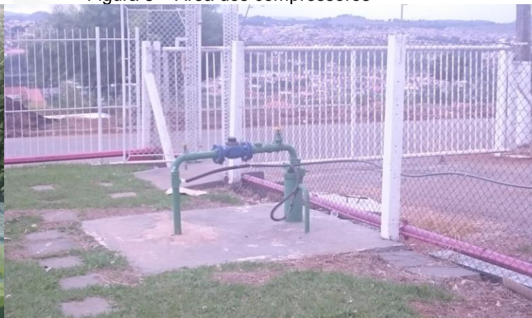
Figura 10 – Poço tubular existente
