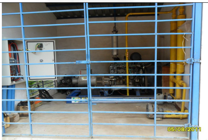
Figura 11: Um dos geradores acionado por motor a Biogás.
