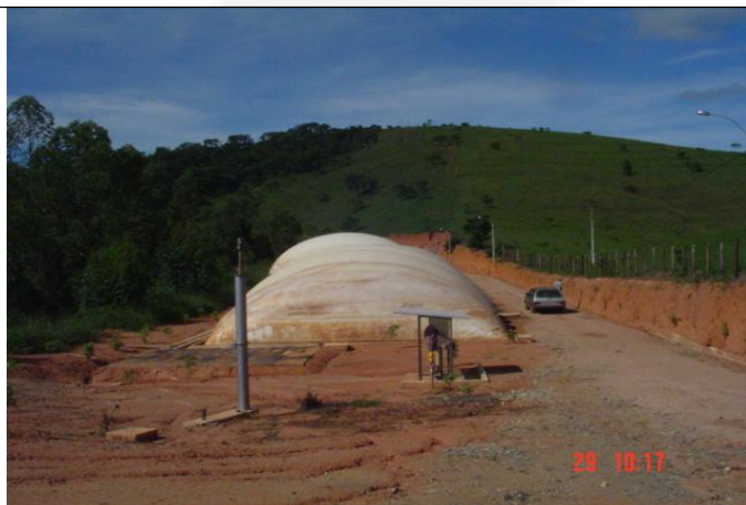
Figura 9: Biodigestores.
