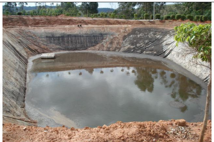
Figura 10: Lagoa com efluentes destinados a ferti-irrigação.
