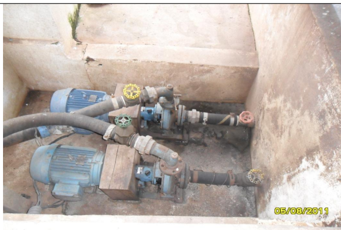
Figura 7: Bombas para recalque de efluentes para os biodigestores.
