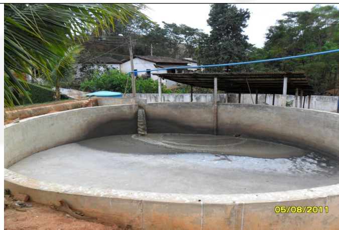
Figura 6: Tanque equalizador de efluentes.
