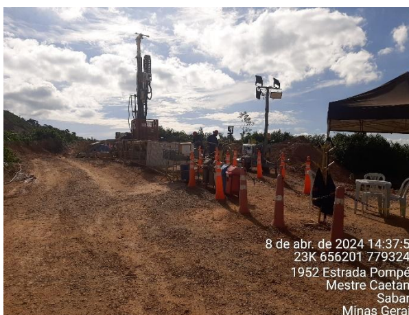
Foto 1: Praça de sondagem localizada nas coordenadas UTM 23k 647331 / 779328.
