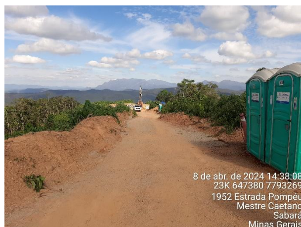
Foto 2: Praça de sondagem localizada nas coordenadas UTM 23k 647409 / 7793204.
