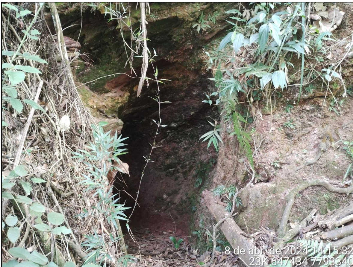
Foto da entrada da Galeria.
