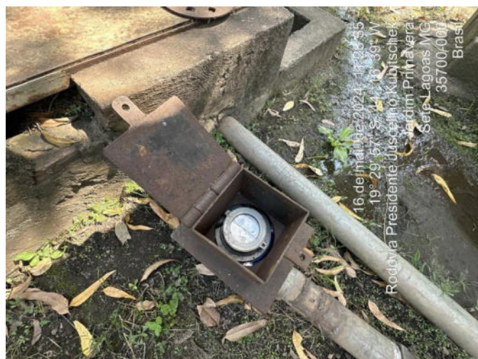
Foto 83 - hidrômetro do poço 01
