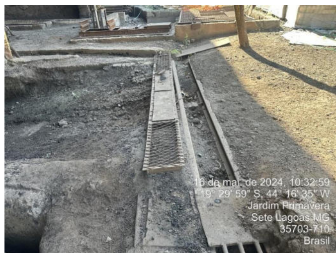
Foto 56 - Canaleta que contempla sistema de drenagem pluvial do empreendimento. Tal estrutura se encontrava com muito material, necessitando de limpeza
