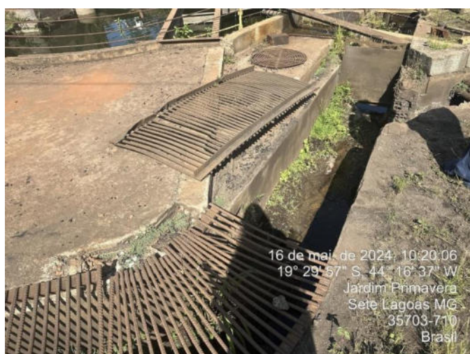
Foto 43 -Canaleta que contempla sistema de resfriamento do alto-forno
