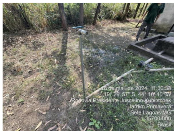
Foto 36: Torneira para coleta da água dos poços.
