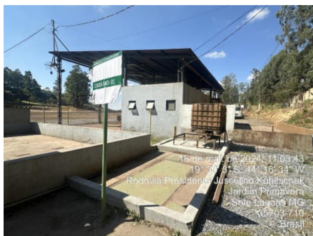
Foto 23: CSAO associada ao ponto de abastecimento de combustíveis.
