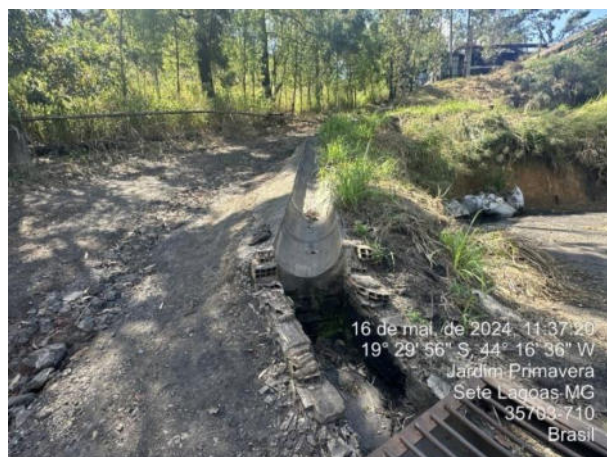
Foto 14: Canaleta que compõe o sistema de drenagem ao longo de acesso na área operacional.
