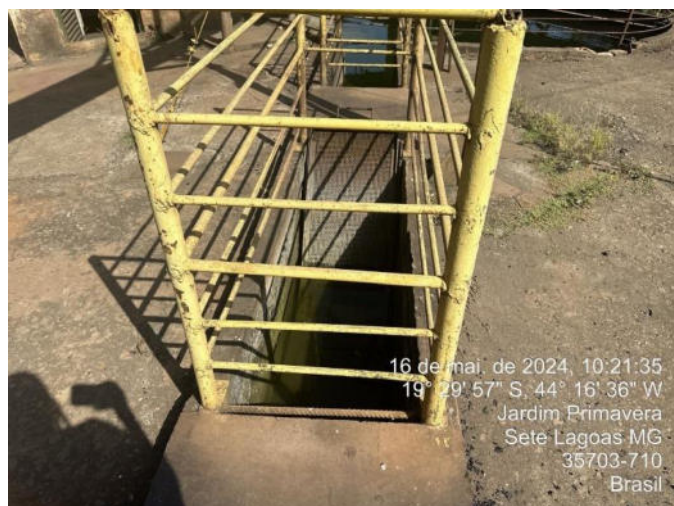
Foto 44 - Canaleta que contempla sistema de resfriamento do alto-forno
