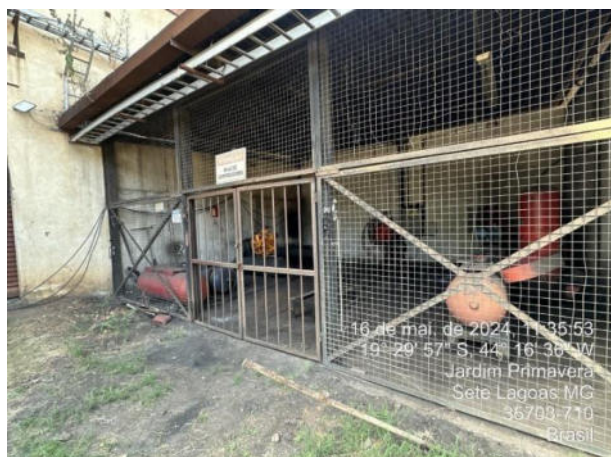
Foto 25: Área dos compressores, sem contenção
