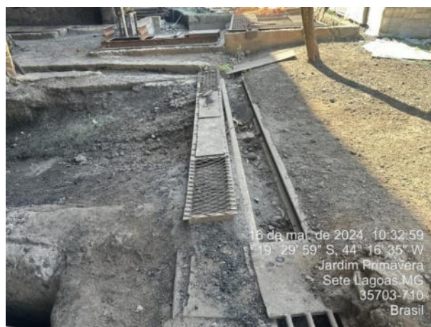
Foto 10: Canaleta do sistema de drenagem pluvial do empreendimento. Esta porção da canaleta apresenta material
