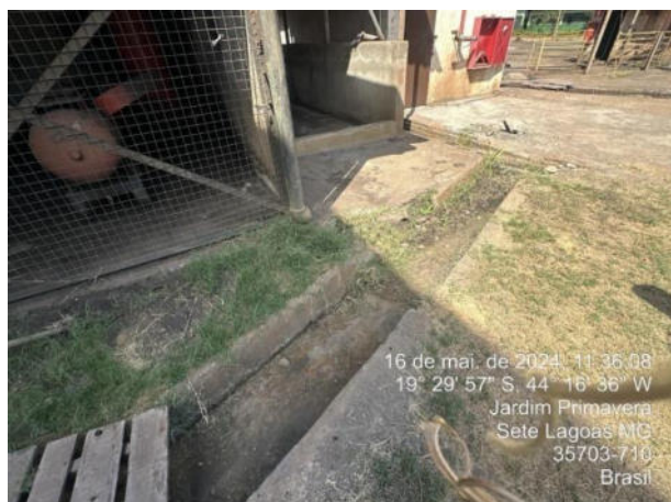
Foto 13: Canaletas próximo a sala dos compressores.
