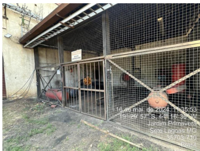
Foto 88 - área dos compressores, com canaleta mas sem a conexão da mesma até a CSAO
