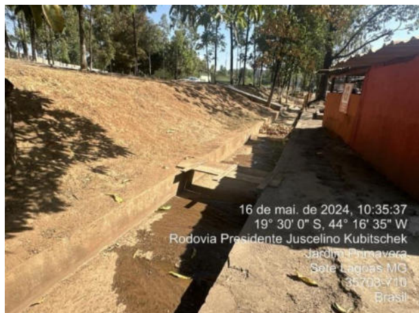
Foto 11: Canaleta de drenagem próximo à área de acondicionamento dos resíduos.
