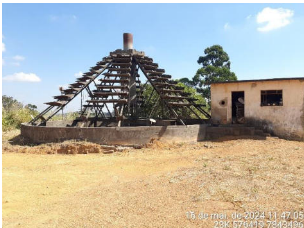
Foto 7: Tanque de resfriamento da água do processo.
