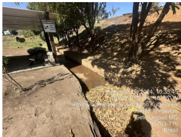
Foto 12: Canaleta de drenagem próximo à entrada do empreendimento, necessitando de limpeza completa
