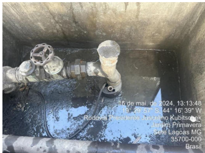
Foto 86 - tubo para medições estáticas e dinâmicas do poço
