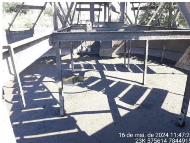
Foto 8: Detalhe interno do tanque de resfriamento de água. Foi possível evidenciar relevante volume de água no tanque.
