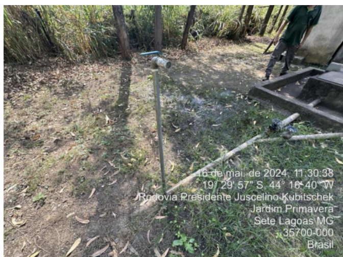
Foto 85 - torneira para coleta da água dos poços
