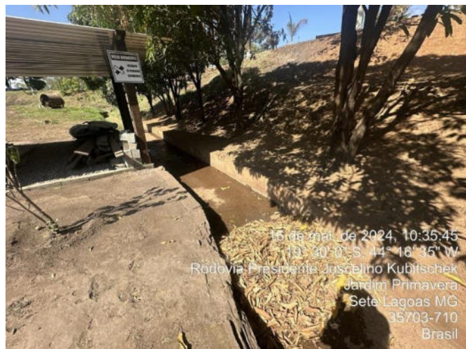
Foto 58 - Canaleta de drenagem próximo à entrada do empreendimento, necessitando de limpeza completa
