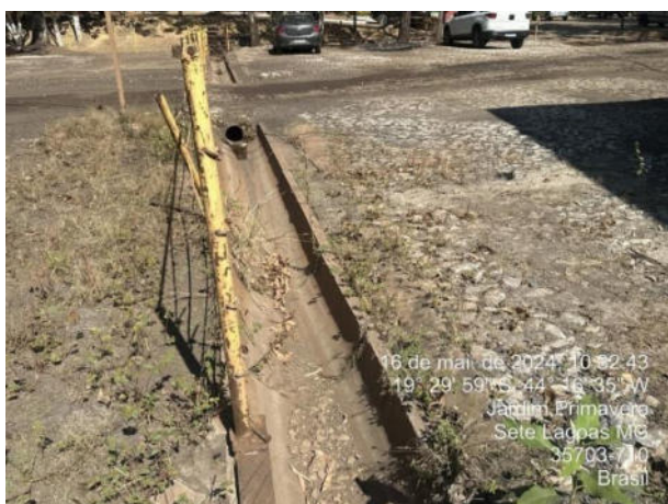
Foto 9: Canaleta ao longo de acesso que compõe parte do sistema de drenagem pluvial do empreendimento.
