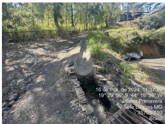
Foto 60 - Canaleta de drenagem na descida do terreno
