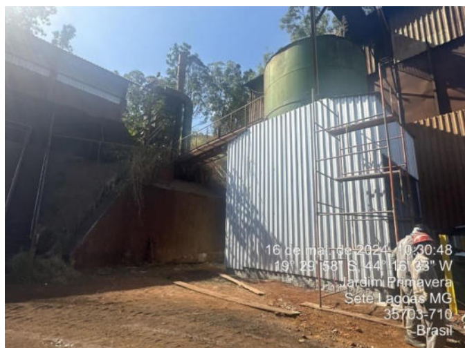
Foto 51 - Enclausuramento sendo realizado na estrutura da planta da siderúrgica
