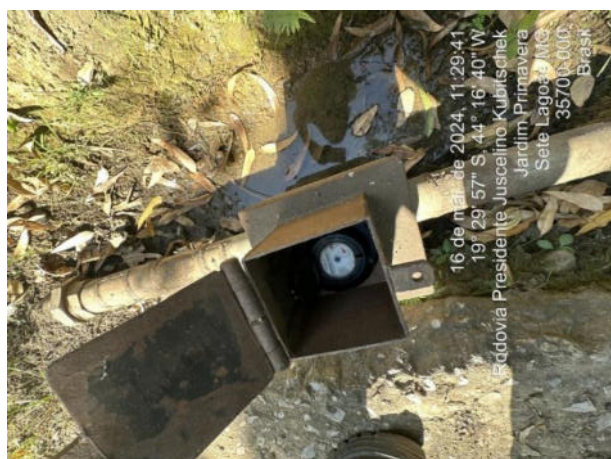
Foto 35: Hidrômetro do poço 02
