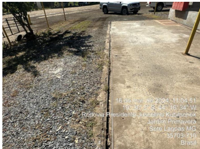
Foto 76 - canaletas da área de abastecimento de combustível
