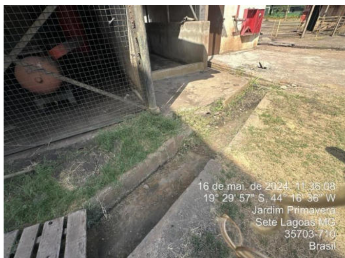
Foto 59 - Canaleta de drenagem próximo à sala dos compressores
