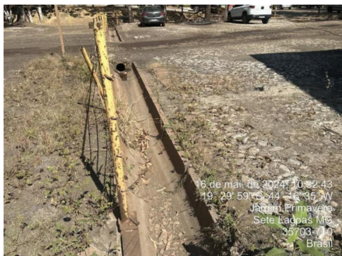
Foto 55 - Canaleta que contempla sistema de drenagem pluvial do empreendimento
