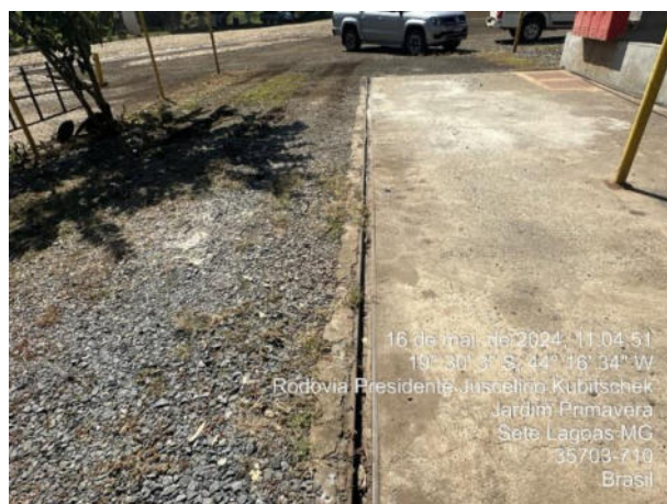
Foto 30: Canaletas na área de abastecimento de combustível
