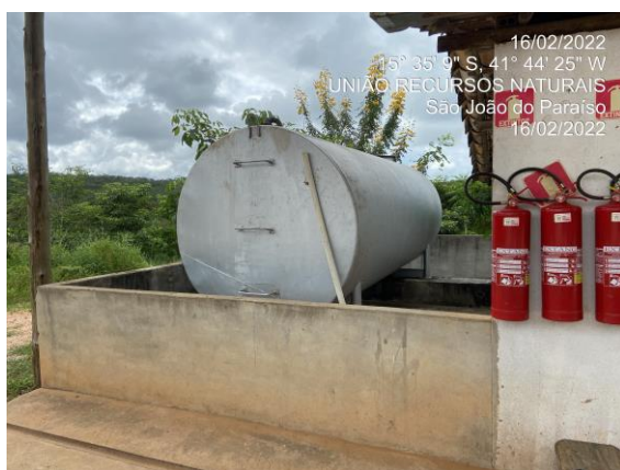
Foto 4 - Tanque de armazenamento de combustíveis do empreendimento.
