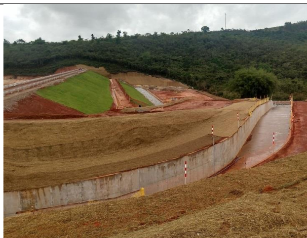
Figura 4: Fluxo residual a jusante Dique 4
