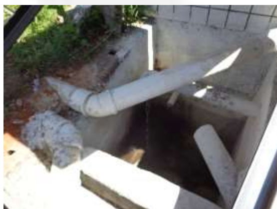
Foto 03. Saída do efluente oleoso tratado.
