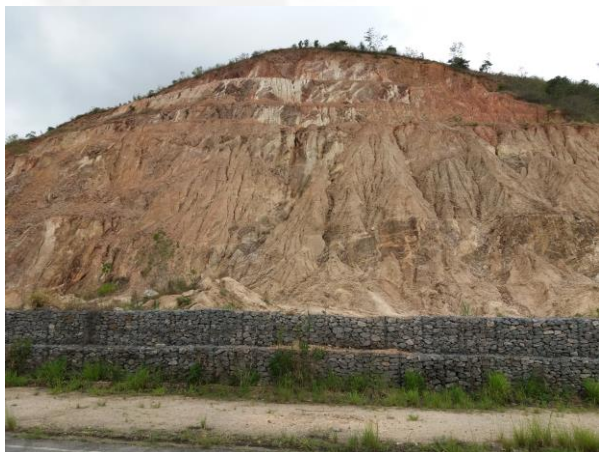
Fotos 3 e 4 – Jazida José Marcio, com presença de sulcos erosivos e carreamento de sedimentos.
