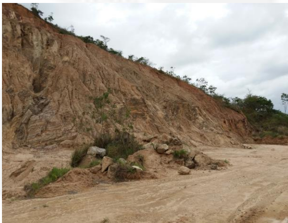
Fotos 3 e 4 – Jazida José Marcio, com presença de sulcos erosivos e carreamento de sedimentos.
